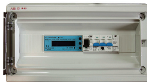
Rysunek 2. Szafka zasilająco-sterownicza przepompowni z zasilaniem 1-fazowym
