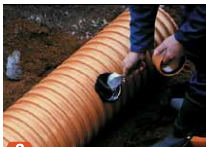
2 Gummiring monteres og påføres glide-middel.
