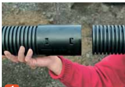
1 Skjøtemuffe monteres inn på den ene rørenden.
