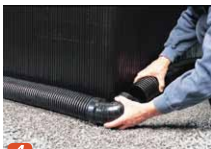
4 Bruk ALLTID bend rundt hjørner!
