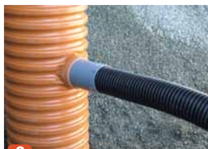
2 Monter drensrør i drenstilkobling.
