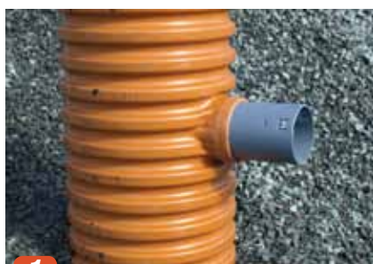
1 Muffen på drenskummen påføres glide-middel. Drenstilkobling benyttes ved av Wavin korrugerte drensrør 83/100 mm.
