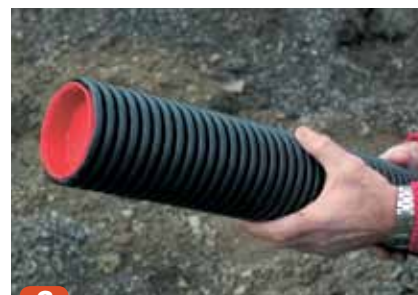
3 Benytt endedeksel for unngå masse i ledningen.
