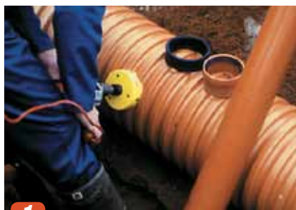
1 Det bores hull med 127 mm hullsag.
