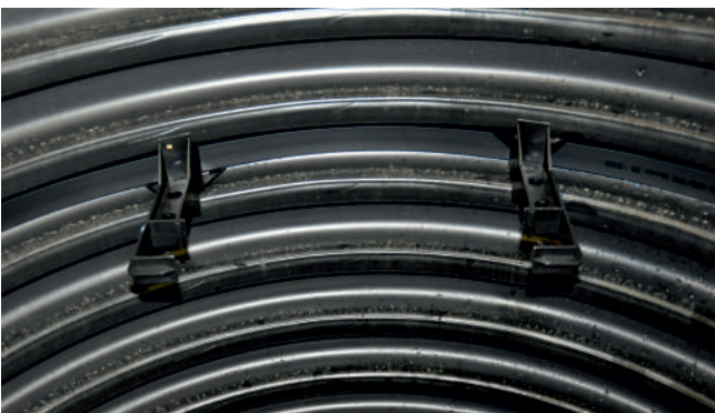
Išankstinis lipynės laikiklio montavimas šachtiniame vamzdyje
