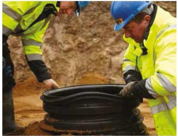
Om förhöjning (utöver konan) monteras en TEGRA 600 tätning i korrugeringen överst på konan (utvändigt). OBS! Bara i det fallet som förhöjning utöver konan skall utföras!
