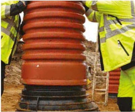
Om förhöjning (utöver konan) kan ett TEGRA 600 stigarrör monteras. Det måste vara ett stigarrör med muff i ena änden. Ett sådant stigarrör finns i längder om 1,5 och 3,5m längd
