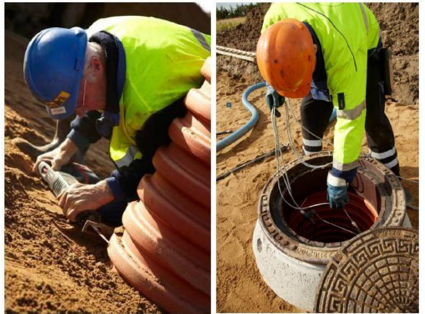
Kapa förhöjningen och gör en genomföring för nivåalarmets kablage. Det utförs lämpligen innan betäckningen monteras. Håll koll på hur mycket betäckningens ram bygger nedåt inuti förhöjningen! Om tät toplösning önskas så montera en invändig tättningsring överst i röret.
