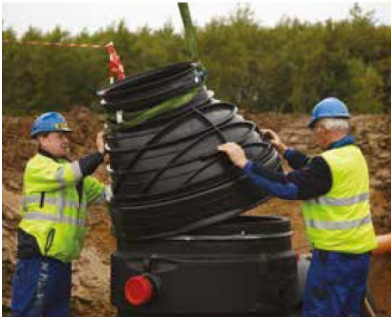
Montera TEGRA 1000 konan med konans raka del vänd mot tankens utlopp! (för möjlig åtkomst till utloppet)
