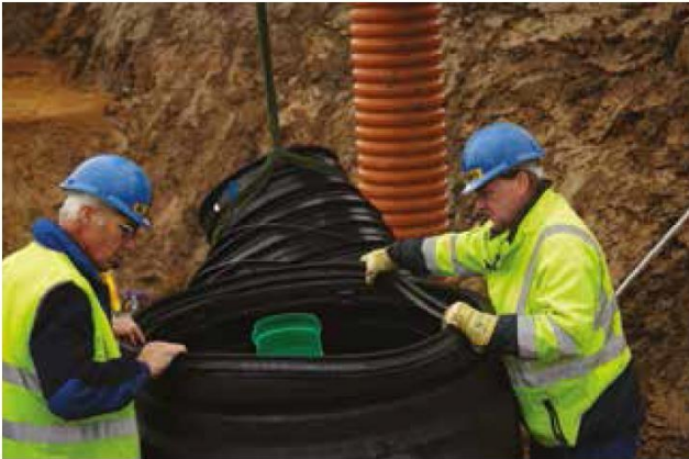
Montera en TEGRA 1000 tättningsring i spåret över öppningen, överst på tanken
