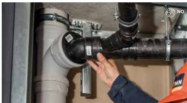
Figur 14: Eksempel på hvordan man lager en utkravning
