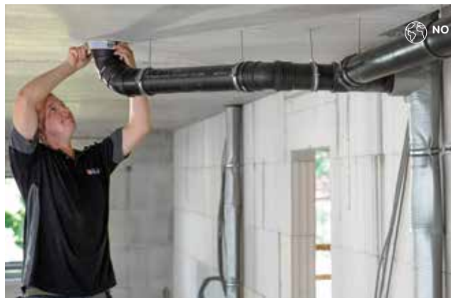
Figur 39: Avløpsrør med lydisolerende slange
