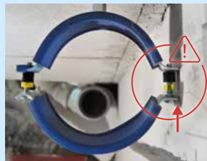
Figur 40: Justere rørklammerne på riktig måte
