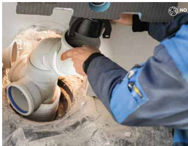
Figur 42: Plassere et avløpssystem for en gulvplate
