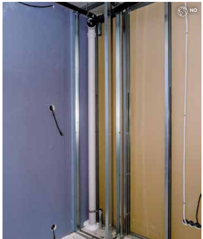
Figur 12: Gipsvegger med fester mot tak og gulv
