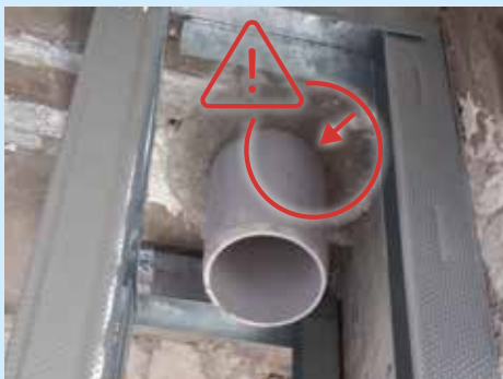
Figur 20: Glemt lyddemping av strukturbåren lyd
