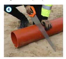
Si nécessaire, il est également possible de raccourcir les tuyaux Acaro PP SN 12 à la longueur nécessaire, sur site. Pour ce faire, le tuyau doit être scié de façon perpendiculaire à l'aide d'une scie à dents fines. Les pièces auxiliaires ne doivent pas être raccourcies. Une fois le tuyau raccourci, toutes les bavures et imperfections doivent être supprimées à l'aide d'un outil approprié, par exemple un rabot.
