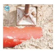
Enfin, la tranchée doit être rebouchée conformément à la norme NBN EN 1610, couche par couche, en couches de 30 cm de haut maximum, puis cette couche doit être tassée. De plus, le remplissage et le tassage sur les côtés, surtout à l'amorce, doivent être effectués très soigneusement à l'aide d'une machine à vibrations légère.
