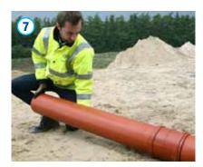
Les tuyaux de diamètre nominal plus petit peuvent facilement être insérés manuellement les uns dans les autres. De ce fait, il est également possible de réaliser de petites modifications de direction en plaçant le tuyau à un angle maximum de 0,5° dans le manchon. Cela équivaut à 5 cm sur 5 m. La position du tuyau doit être contrôlée et, si nécessaire, être corrigée une fois le raccordement réalisé.
