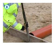
Pour l'insertion les uns dans les autres de tuyaux d'un diamètre nominal plus important, il est possible d'utiliser des accessoires, tels qu'une barre.
