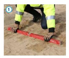
Acaro PP SN 12 doit être installé conformément à la norme NBN EN 1610. Pour cela, une couche plate de graviers ronds ou de sable de concassage doit être réalisée. En ce qui concerne la grosseur des graviers ronds, on utilisera, en fonction du diamètre nominal du tuyau, une taille maximale de 22 mm jusqu'à un diamètre intérieur / extérieur de 200 et une taille maximale de 40 mm jusqu'à un diamètre intérieur / extérieur de 500. Pour le mortier, la taille des graviers ne doit pas dépasser 11 mm.
