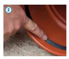
Pour le montage, toutes les pièces doivent être contrôlées afin de détecter toute trace éventuelle de dommages, et être nettoyées si nécessaire. L'extrémité d'insertion et la paroi interne du manchon doivent être propres et exemptes de dommages ; à défaut, il faut nettoyer ou remplacer le tuyau. Il faut vérifier si les joints s'adaptent bien dans le manchon.
