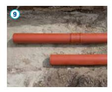
Entre l'installation et le remplissage de la tranchée, les tuyaux doivent être installés conformément aux spécifications du plan et du fabricant en ce qui concerne la hauteur et l'orientation. Cela peut être réalisé en effectuant des contrôles visuels réguliers, en soutenant l'ensemble avec des tas de sable ou en installant des poteaux.
