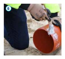
L'extrémité d'insertion marquée doit ensuite être lubrifiée sur tout le pourtour et être enfoncée dans le manchon, jusqu'à la butée.
