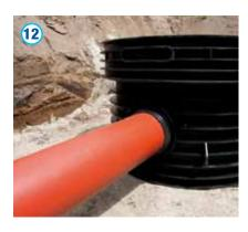
Pour le raccordement sur des chambres d'inspection Wavin Tegra, celles-ci étant livrées directement avec des manchons à joint à rotule complets, il est aussi facile de connecter les tuyaux à la chambre de la même manière que dans le cas d'un raccordement de deux tuyaux entre eux.
