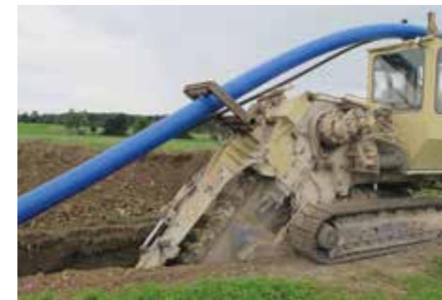
22. ábra: Keskeny árokásásos csőfektetés
