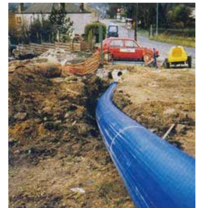
27. ábra: Csőbehúzás (Sliplining)
