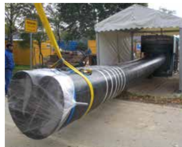
29. ábra: Helyszínen szűkített szorosan illeszkedő bélés (Subline)
