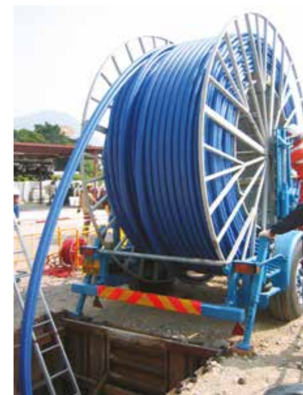
30. ábra: Gyárilag szűkített szorosan illeszkedő bélés (kompakt cső)
