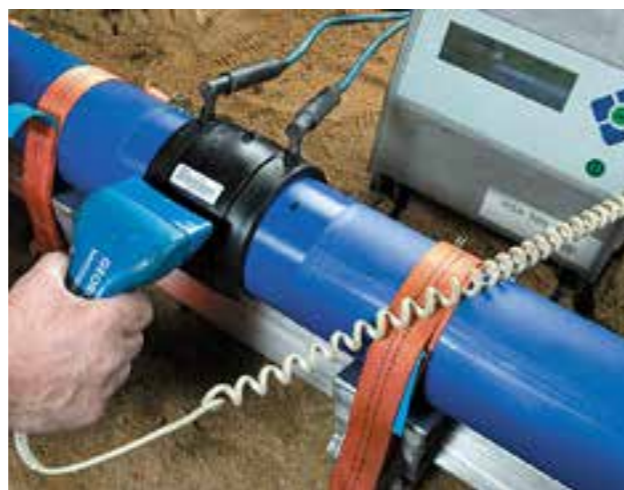
14. ábra: Elektrofúziós hegesztés
