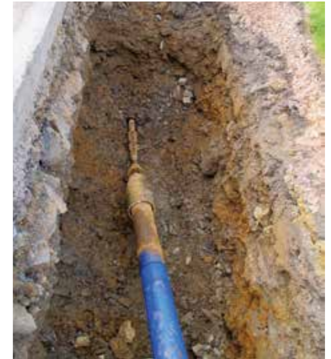
23. ábra: Vízszintes irányított fúrás (HDD)
