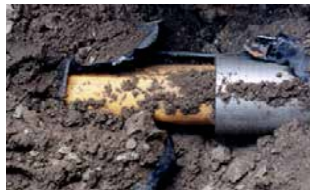
25. ábra: Csőroppantás
