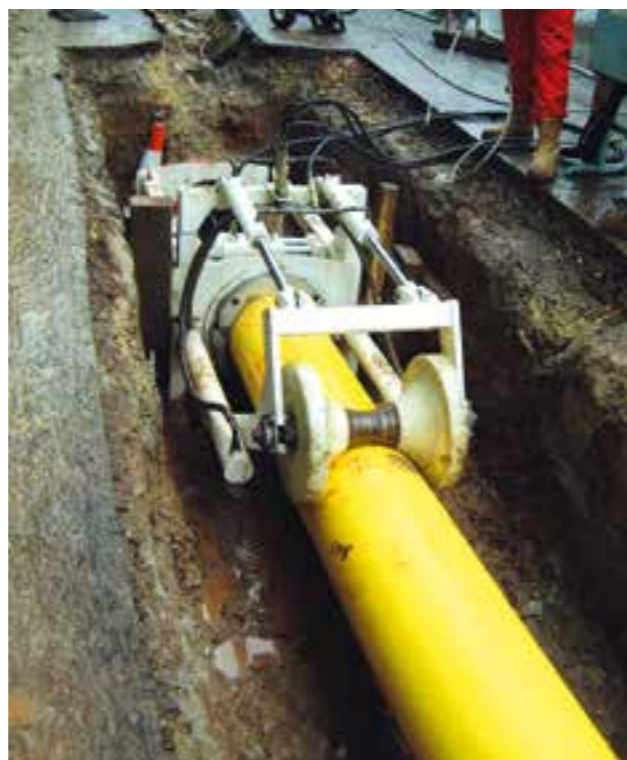
28. ábra: Helyszínen szűkített szorosan illeszkedő bélelés (Swagelining)
