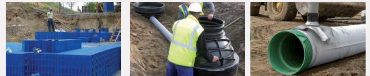
Wavin sistem QuickStream terhubung dengan sistem pengelola air bawah tanah berkelanjutan dimana air hujan disimpan untuk digunakan kembali atau difiltrasi kedalam tanah. Dari cerita ini, Wavin terbukti menjadi spesialis dalam desain dan perencanaan pengelolaan air secara menyeluruh.
