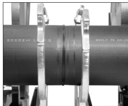
Správně vytvořený svařový spoj natupo
