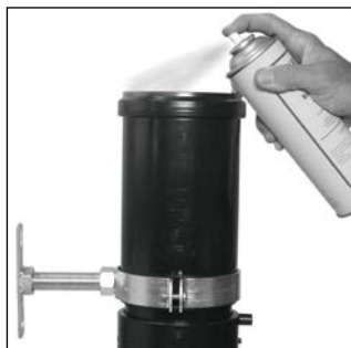
Mazání styčných ploch mezi trubicou a kompenzačním hrdlem
