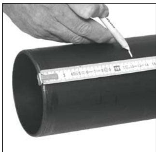
Označení požadované zásuvné délky
