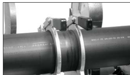
Správně připravené potrubí ke svařování
