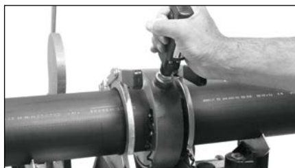
Srovnání konců potrubí integr. hoblíkem
