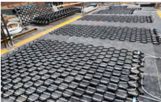
Födémzsaluzatra fektetett Wavin CW-90 regiszter panelek
