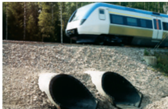
Figur 2.6b: Middelspænding/jorddækning på rør i jord forårsaget af svær trafiklast.
