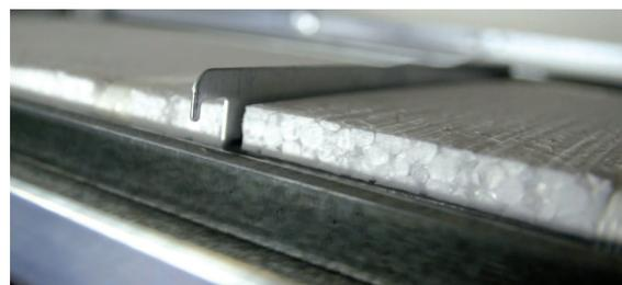
I pannelli di tamponamento saranno fissati in seguito direttamente sui profili metallici della seconda orditura.
