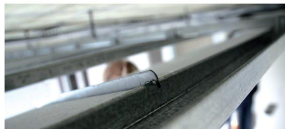
Si consiglia di non avvitare i profili della seconda orditura sul profilo perimetrale in modo da poterli traslare per facilitare le operazioni di fissaggio dei pannelli. Tutte le connessioni idrauliche sono realizzate con raccorderia a innesto rapido push-fit.
