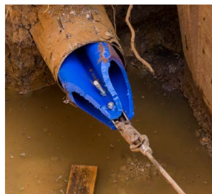
Compact Pipe voda PE 100 RC Hulín – Kroměříž
