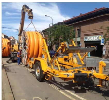
Compact Pipe PE 100 RC plyn Praha, Na Slupi
