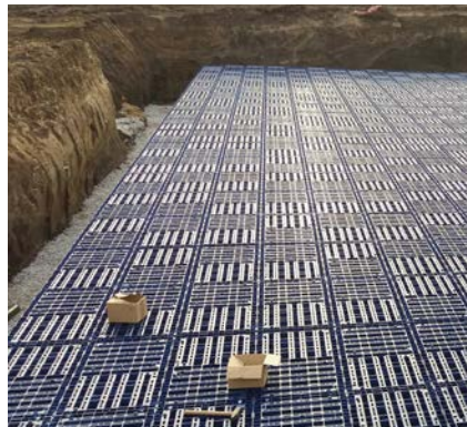
Retenční nádrž pro projekt nemocnice v Hořovicích
