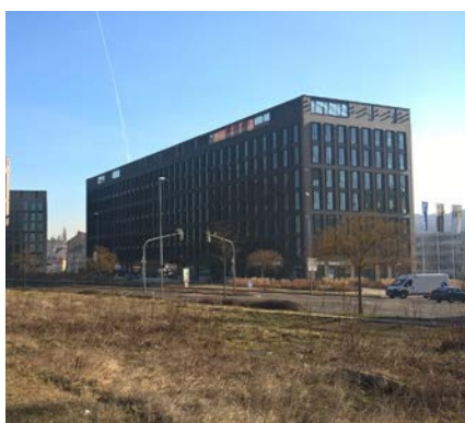
Administrativní budova Rustonka – Praha
