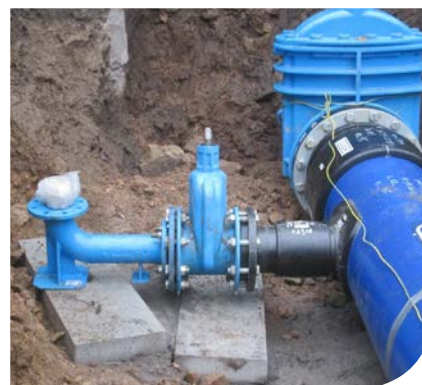
Jihlava – výměna vodovodu ul. Brněnská
