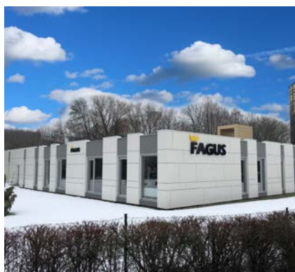
Administrativní budova firmy FAGUS a. s. – Slušovice
