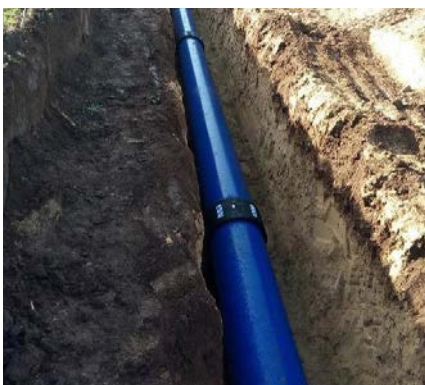
Zaječí – rekonstrukce výtlačného řadu
