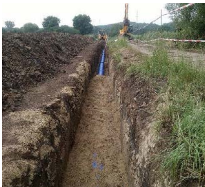
Zaječí – rekonstrukce výtlačného řadu
