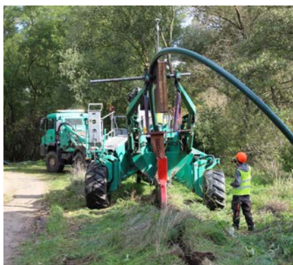
Pluhování Ivančicko – tlaková kanalizace
