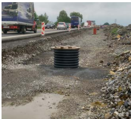
D48 Rychaltice-Rybí – střídání šachet Tegry 600 a Tegry 1000 NG
