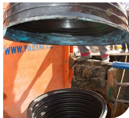
Havířov – instalace přechodového konusu šachty Tegry 1000 NG
