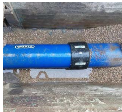
Zaječí – rekonstrukce výtlačného řadu
