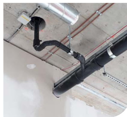
Aviatica Praha – napojení střešního vtoku
