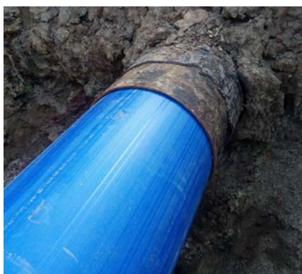
Compact Pipe voda PE 100 RC, Valašské Meziříčí
