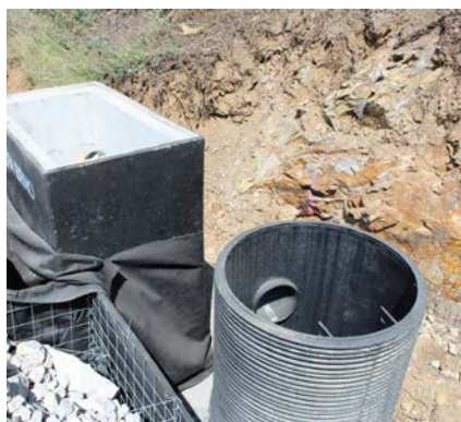
Rekonstrukce dálnice D1 – šachty Tegry 1000 NG
