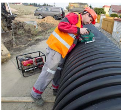
Zkracování šachtové roury Tegry 1000 NG na finální délku
