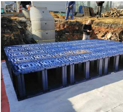
Akumulační boxy Q-Bic Plus v projektu Toyota v Opavě
