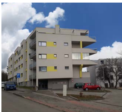
Bytové domy Brno – Sadová
