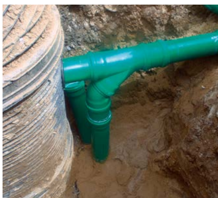
Spadišťová šachta poskládaná z potrubí Wavin KG 2000 PP
