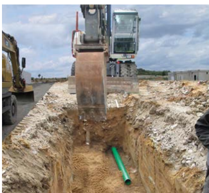
Uložení potrubí Wavin KG 2000 PP v rýze
