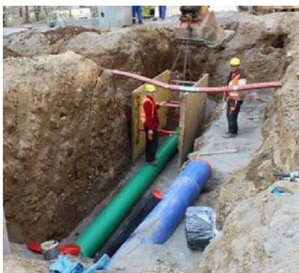
Jihlava – výměna vodovodu ul. Brněnská
