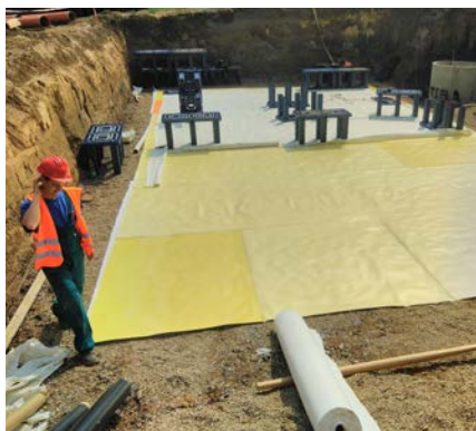
Akumulační boxy Q-Bic Plus – Jihlava - Nové Domky, RN
