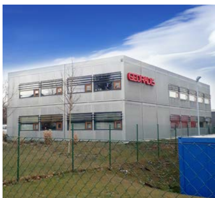
Administrativní budova firmy Georadis a. s. – Brno
