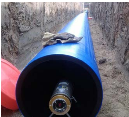
Zaječí – rekonstrukce výtlačného řadu
