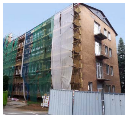
Rekonštrukcia interného pavilónu FNŠP J. A. Reimana – Prešov
