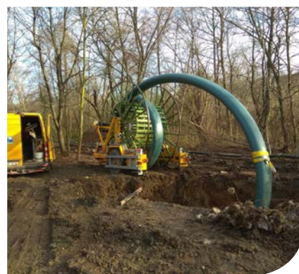
Compact Pipe kanál PE 100 Říčany u Prahy
