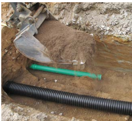
Uložení potrubí Wavin KG 2000 PP a Wavin X-Stream
