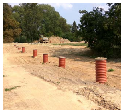
Šachty Tegra 425 jsou velmi oblíbené jako přípojkové domovní revizní šachty
