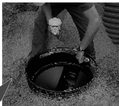
2 Kringfyllnadsmaterialet fylls till 30cm över rörets topp och komprimeras till de ställda kraven. Muffen där ständarröret skall placeras i brunnen smörjas med smörjmedel. Installationlocket kan användas under installationen.
