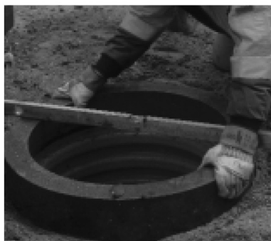
8 Vid installation med fast betäckning används förhöjningsringar.
