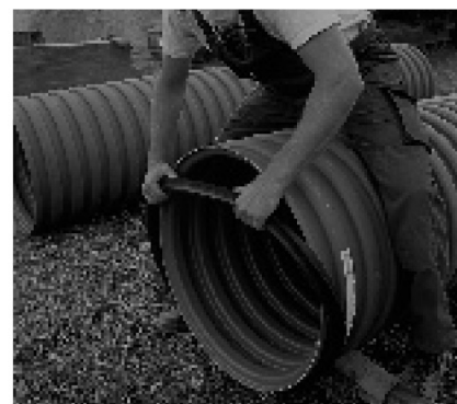
3 Gummiringen placeras i nedersta korrugeringen.
