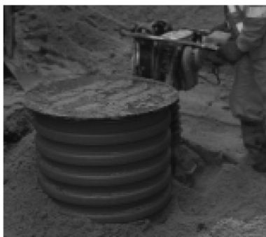
7 Komprimering skall utföras efter de krav som ställs på konstruktionen ovan (ex. vägen). Installationslock kan monteras i toppen på röret.
