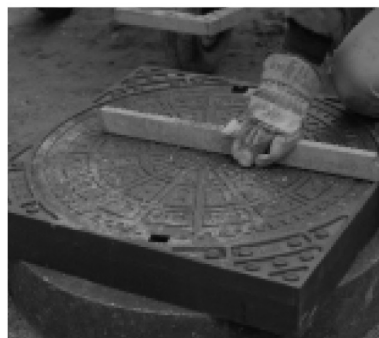
9 Betäckningen är monterad och beläggningen kan nu läggas.
