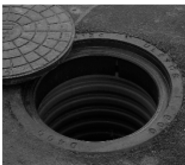
10 Standard flytande betäckningar används till körbara ytor. Betäckningen har en teleskopisk ram som monteras direkt i 600 mm öppningen. Använd ett låsbart lock för att minimera olyckor.
