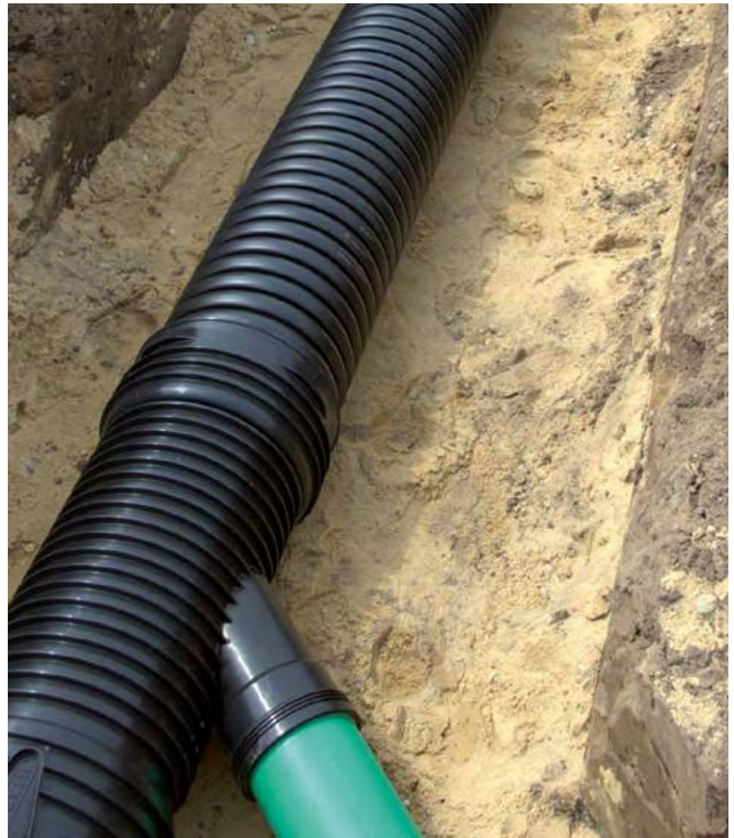
Schneller Anschluss von KG und Green Connect 2000 über Abzweige
