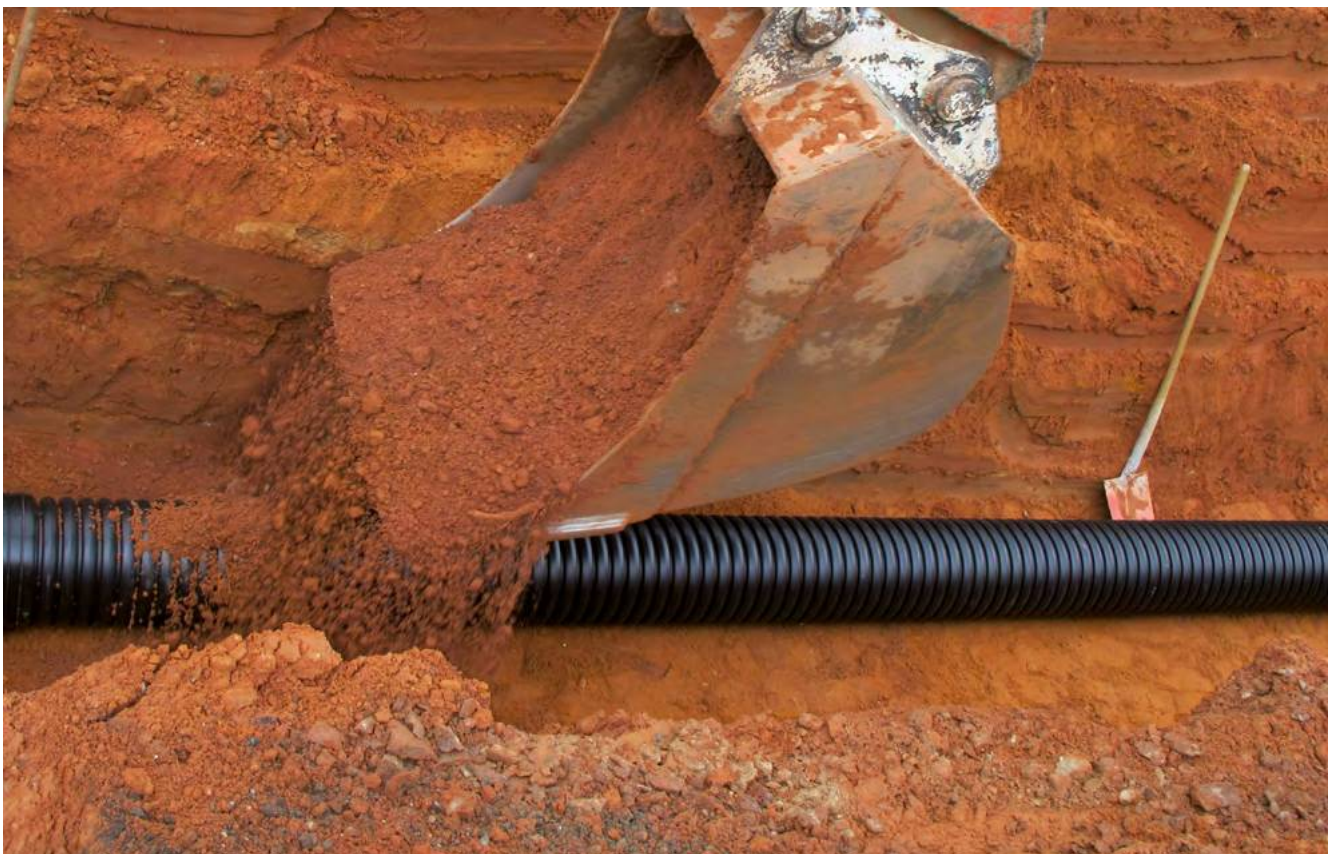
Einfache Lagesicherung durch Sandkegelaufschüttung
