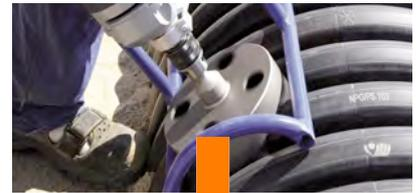
**DE** X-Stream-Sattel ermöglichen einen wasserdichten und sicheren Anschluss von KG-Rohr DN 150 an X-Stream mit Nennweiten DN 250 bis DN 800.
