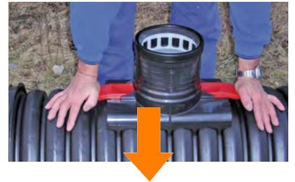
**DE** Sämtliche Grate und Schnittreste am Bohrrand entfernen. Geeignet ist feines Schleifpapier bzw. ein kleines Messer. Den Durchmesser der Bohrung dabei nicht vergrößern.
