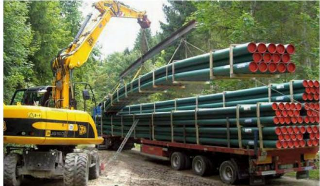
Abb. 1: Stangenware in 20-m-Längen
