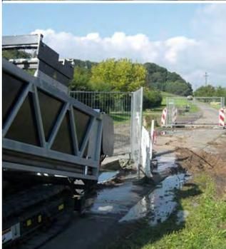
*HDD mit Wavin TS<sup>DOQ</sup>® DA 225 auf einer Länge von 4,5 km von Bleicherode bis Wipperfurth. Verschweißen der Rohrstangen mittels Stumpfschweißen mit Heizelement.*
