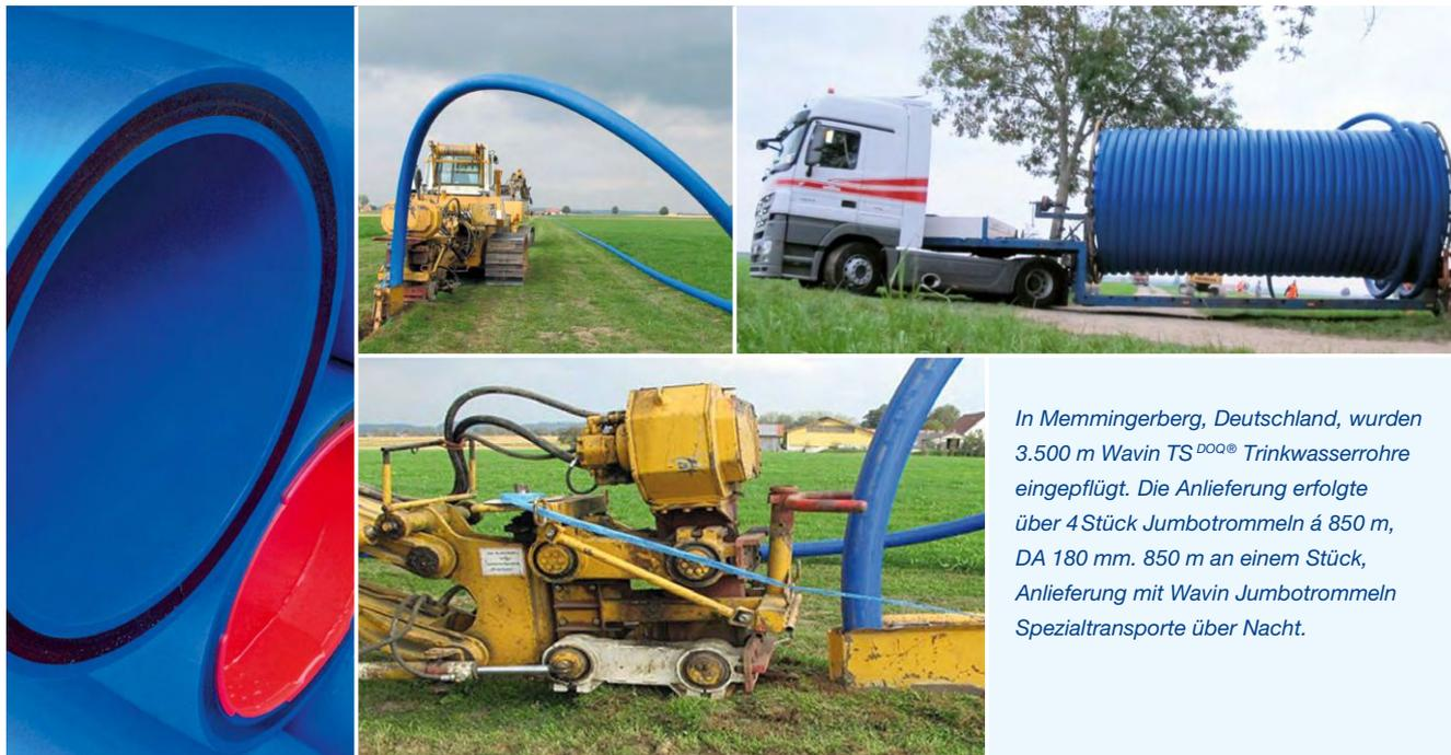
*In Memmingerberg, Deutschland, wurden 3.500 m Wavin TS<sup>DOQ</sup> Trinkwasserrohre eingepflügt. Die Anlieferung erfolgte über 4 Stück Jumbotrommeln á 850 m, DA 180 mm. 850 m an einem Stück, Anlieferung mit Wavin Jumbotrommeln Spezialtransporte über Nacht.*
