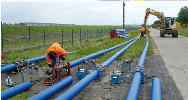
*In der Region Lukavec in Tschechien wurden ca. 10 km Wavin TS<sup>DOQ</sup>® Stangen- und Ringbundware verbaut. Die Trinkwasserrohre wurden in schwer zugänglichen Waldabschnitten eingepflügt und unter Wiederverwendung von Bodenaushub im offenen Graben verlegt.*
