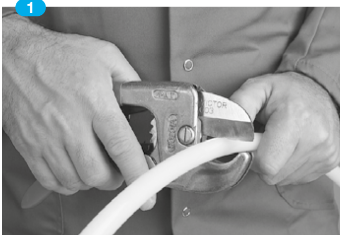
Pex-røret afkortes vinkelret. Det gøres nemt med en rørsaks.
