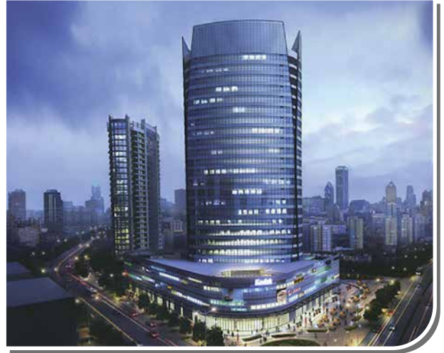
◎ 上海 汇京国际广场
