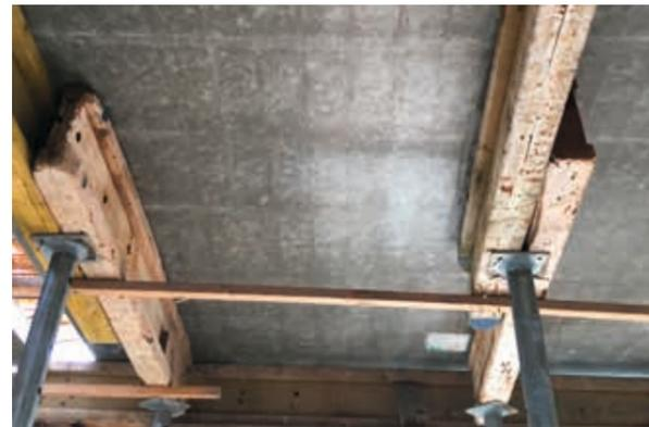
Abb. 10: Filigrandecke mit integriertem CW-90 Modul nach dem Ausschalen
