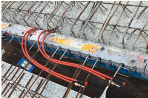
Abb. 9: Betonfertigteil mit integrierten CW-90 Registern mit druckgeprüften Anschlüssen
