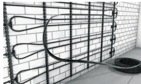
Abb. 6: Montage des WW-10 Systemrohrs
