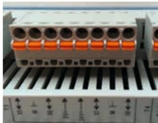
Abb. 12: Klemmblock an Automationsstation
