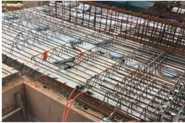
Abb. 8: Filigrandecke mit integrierten CW-90 Registern nach dem Auflegen auf der Baustelle
