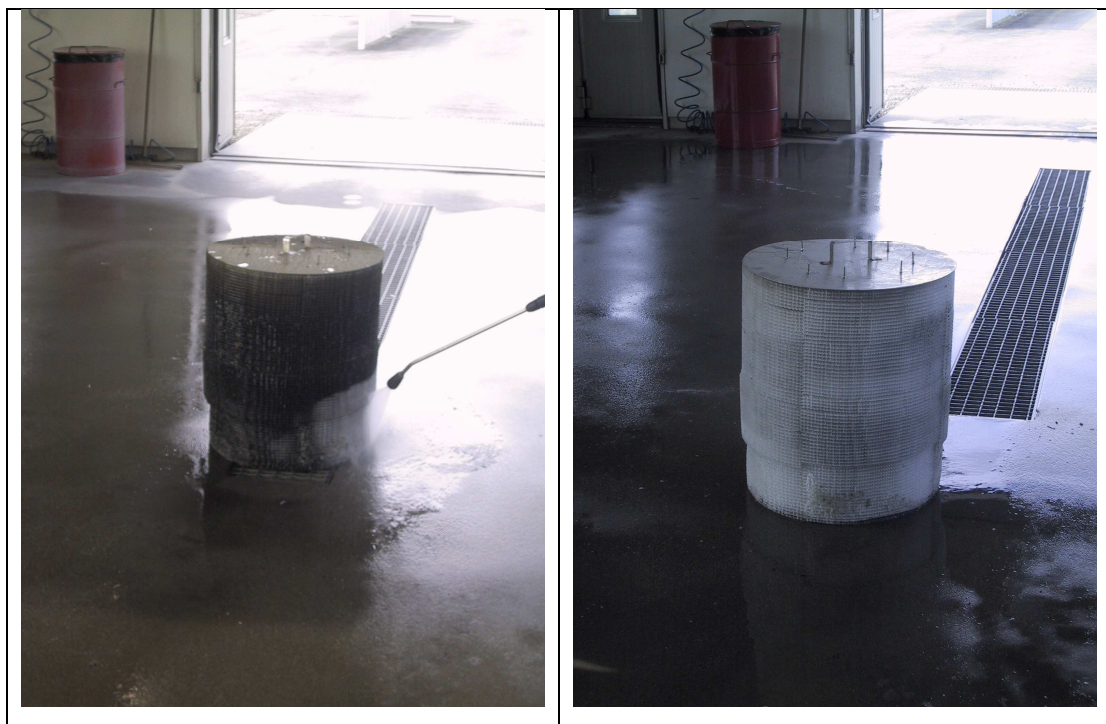
Kuva 8. Koalisaattorin puhdistus painepesurilla ja koalisaattori puhdistuksen jälkeen.
