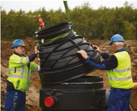
Nosta Tegra 1000 huoltokaivon kartio erottimen päälle. Huoltokaivon epäkeskeisen kartion suora osuus tulee asentaa erottimen lähtöyhteen puolelle, jotta erottimen lähtöyhteen tarkastus on mahdollista.
