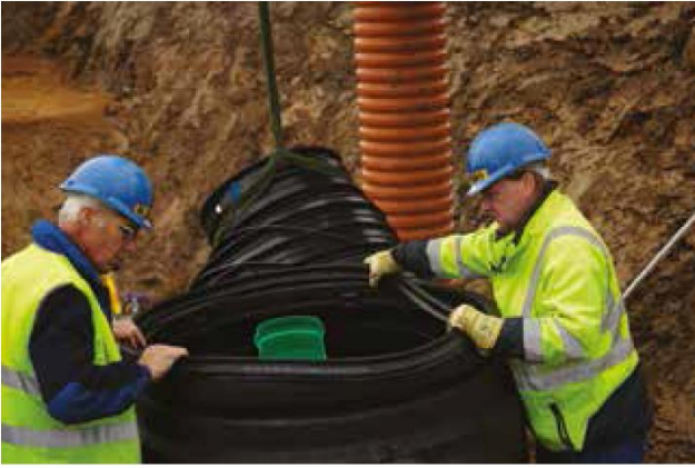
Laita Tegra 1000 tiiviste erottimen rungossa olevaan uraan.
