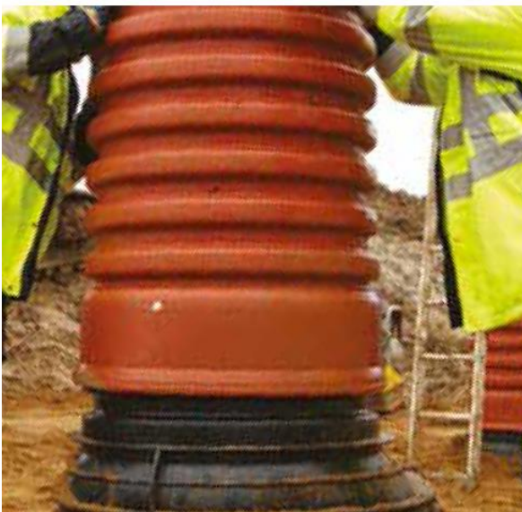
Paina Tegra 600 nousuputki paikalleen.
