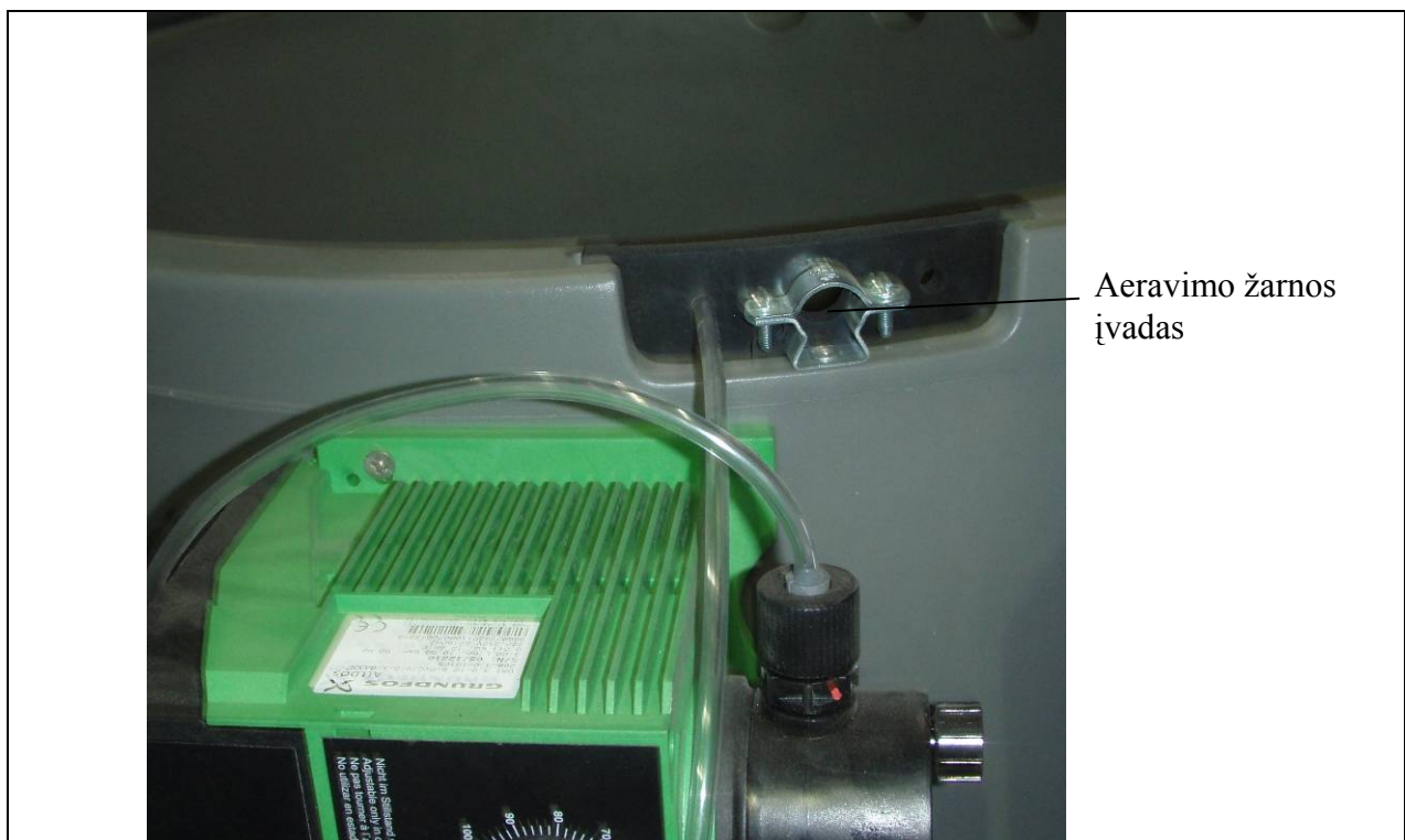
14 pav. Kompresoriaus aeravimo žarnos įvadas į darbinį baką (iš įrangos konteinerio).
