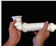
4- Lavabo süzgecini dirseğin üst rakoru altına saat yönünde çevirerek monte ediniz. Rakoru sıkarak contayı sıkıştırınız. 432'lik HepvO bağlantısı için kit içinde yer alan conta ayrıca kullanılmıdır.
