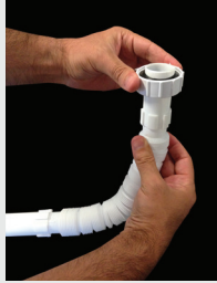
2- HepvO Koku Önleyici diyaframın çıkış tarafının rakorunu sökünüz ve körük hortumunu birleştiriniz.
