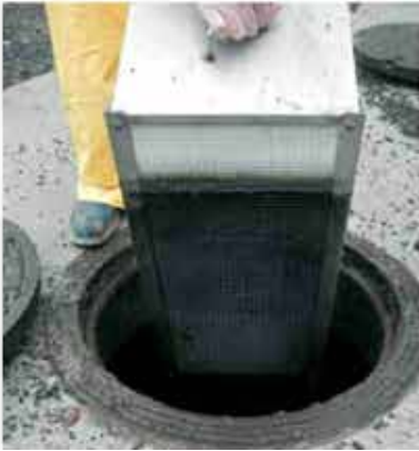
Adım 1: Koaliser filtre kolayca çıkarılır.
