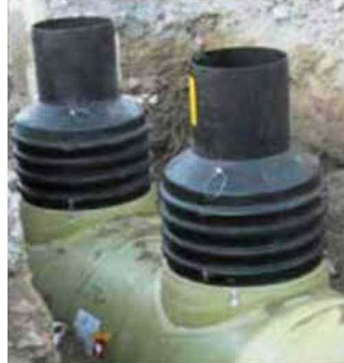
Şekil 6: EuroHUK 600 muayene bacası uygulaması
