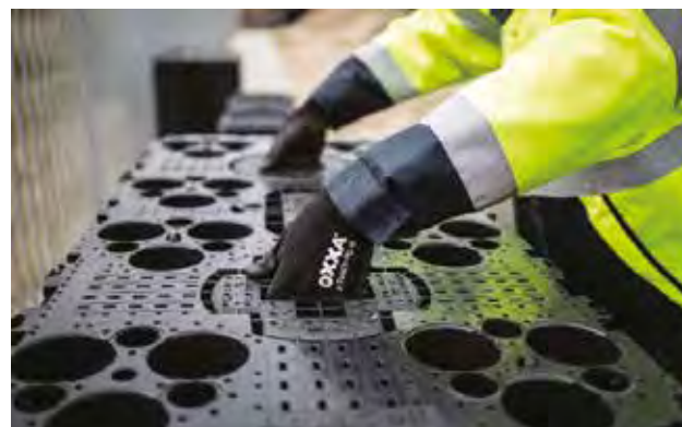
Rys. 17. Montaż zbiornika AquaCell - ergonomiczne uchwyty.
