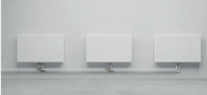
Fig. 47 : Le système de chauffage classique à 2 tubes.
