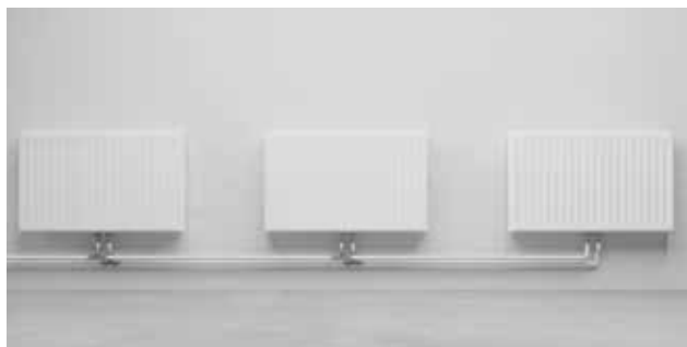
Rys. 45: Dwururowa instalacja ogrzewania grzejnikowego.
