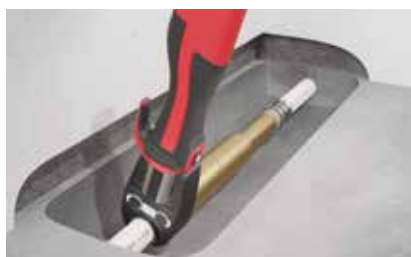
Rys. 30: Montaż złączki naprawczej.
