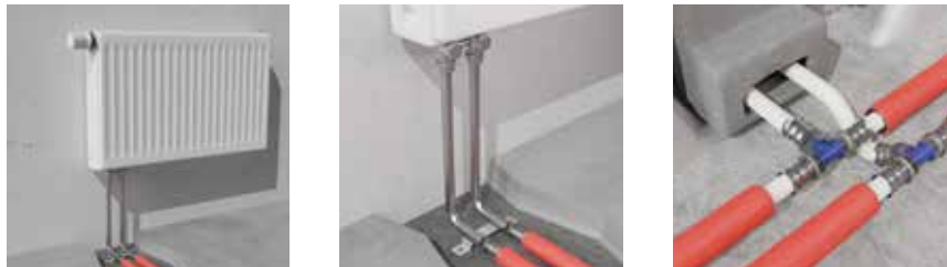
Rys. 48: Przykłady podłączeń grzejników przy użyciu przyłączy kątowych.
