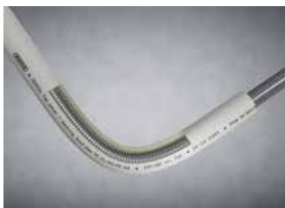
Rys. 28: Gięcie rury za pomocą sprężyny.
