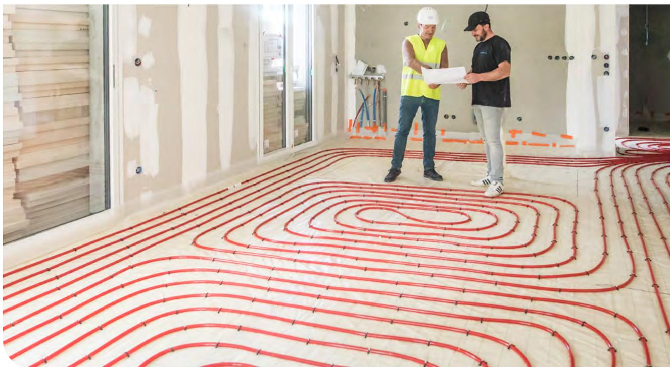
Véritable support du système, la dalle isolante doit non seulement assurer l'isolation de la pièce des éventuelles échanges thermiques avec le sol et réduire les pertes au dos pour favoriser le rayonnement dans la pièce, mais doit aussi assurer la reprise de charge de la dalle de finition avec parfois un besoin de performances acoustiques. Pour répondre à ces besoins, Wavin vous propose 3 types de dalles suivant vos besoins.
