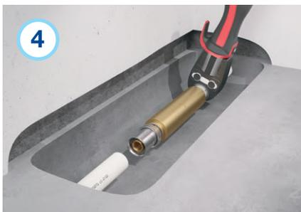
Montierte Verbindung verpressen.
