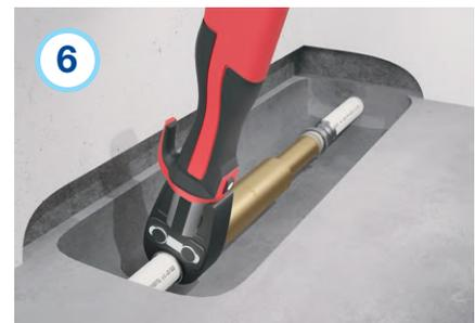
Zweite montierte Verbindung verpressen.
