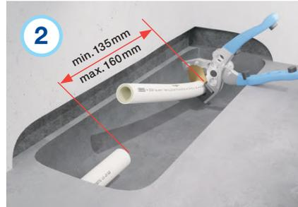
Beschädigte oder undichte Rohrbereiche ausschneiden.
