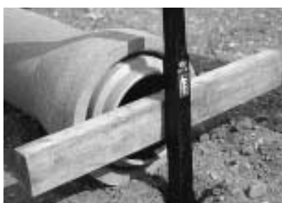
7) Overgangen skubbes på plads
