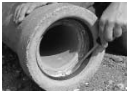
2) Muffen renses for eventuelle grater og rester af beskyttelsesringen
