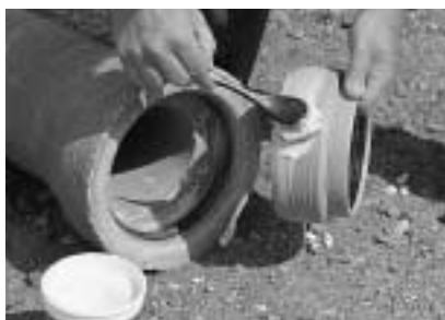
4) Muffen og PVC-overgangen smøres med glidemiddel
