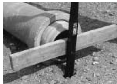
6) Et stykke træ placeres mellem overgang og spyd/greb
