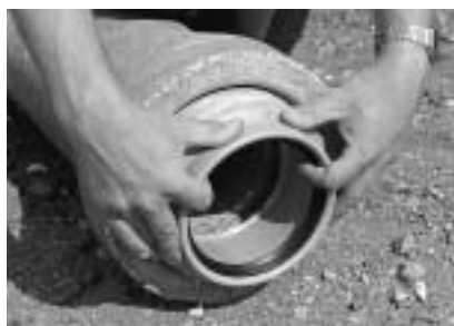
5) Overgangen sættes i muffen. Drej den et par gange frem og tilbage for at sikre centrerung
