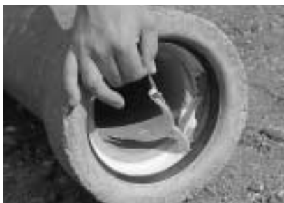
1) Beskyttelsesringen i betonmuffen fjernes
