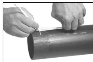
Označení požadované zásuvné délky
