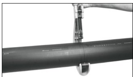
Řez potrubí ruční rotační řezačkou
