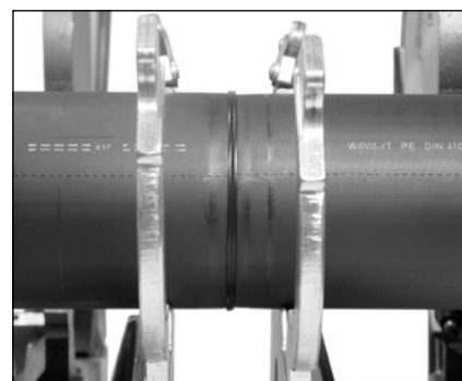
Správně vytvořený svarový spoj na tupo
