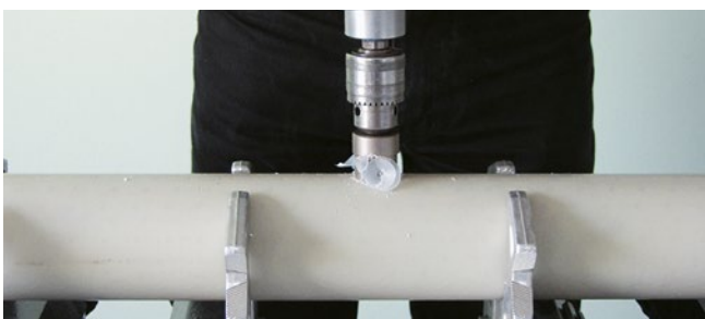
1/ Speciálním vrtákem vyvrtáme otvor pro potrubí.
