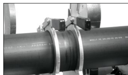
Správně připravené potrubí ke svařování
