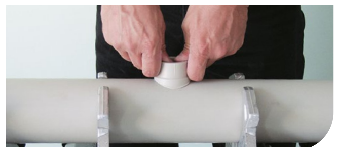
4/ Nahřáté sedlo nasuneme do nahřátého otvoru a fixujeme. Po uplynutí jedné hodiny lze napustit vodou a namáhat tlakem.
