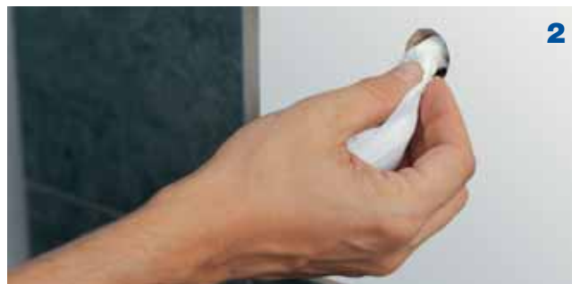
Szárítson és zsírtalanítson. Mérje meg és jelölje a beillesztési mélységet a tűskén, a megfúrt cső falvastagságától függően + 2 mm-re állítsa be a távtartó gyűrűt a hegesztőfej tűskéjén.
