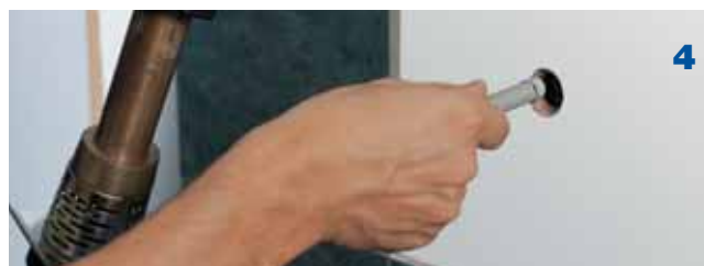
Illessze be a javító tűskét lassan és forgatás nélkül a felmelegített lyukba.
