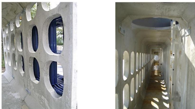
**Figure 12 : Vue de la galerie d'accès en cours de mise en œuvre**
