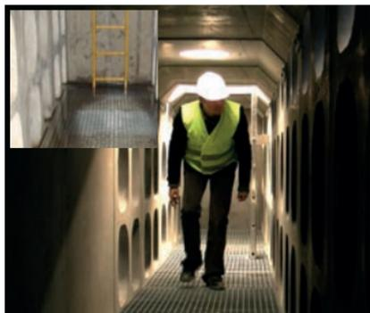
La galerie technique est accessible physiquement par les opérateurs au moyen d'échelles d'accès. À l'intérieur un grand espace de travail est disponible : 1.20 mètre de large x jusqu'à 2.20 m de hauteur. Il est circulaire à pied grâce au caillebotis métallique présent au fond des cadres. L'utilisation des équipements d'inspection et de nettoyage est donc grandement simplifiée.
