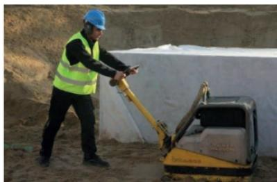
L'usage d'une pilonneuse vibrante de classe PN3 ou à percussion de classe PP2 (Cf. NF P 98-736 Tableau 8) est recommandé pour cette opération.
