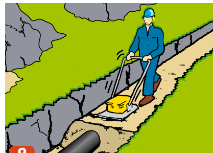
9 Gjenfylling opp til terrengnivå skal skje slik at man tilfredsstiller krav til bæreevne.
