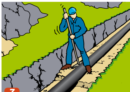
7 Det er viktig å pakke materialet godt sammen under nedre kvartsirkel av røret.
