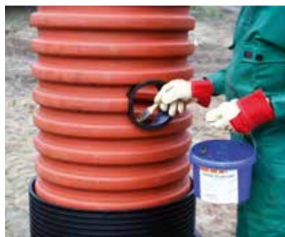
2. Następnie oczyszcza się krawędzie otworu z zadziorów.
