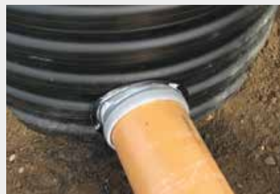
6. Tak zamontowana wkładka in situ gotowa jest do umieszczenia w niej rury kanalizacyjnej.
