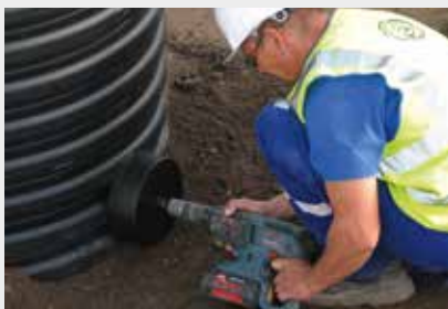
2. Następnie oczyszcza się krawędzie otworu z zadziorów.
