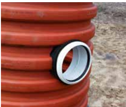
5. Wnętrze zamontowanej uszczelki smaruje się środkiem poślizgowym, co pozwala na zamocowanie w niej kształtki kielichowej.
