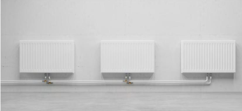
Figure 41 : Chauffage par radiateurs bitubes.
