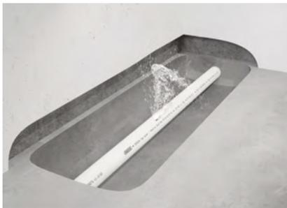
1. Dégagez la zone autour de la partie qui fuit lorsque le tube est installé dans du plâtre ou du béton par exemple.
