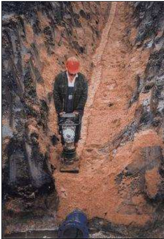
Vibrering på forsøgsstrækning lagt i henhold til DS 430/DS 475
