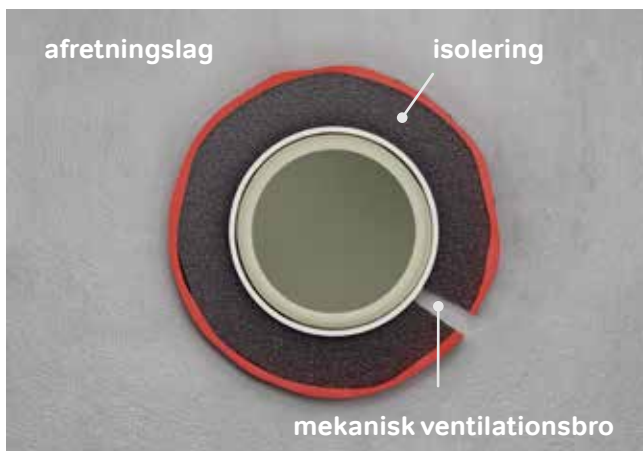
Fig. 41: Mekanisk vibrationstransmission gennem defekt rørisolering.
