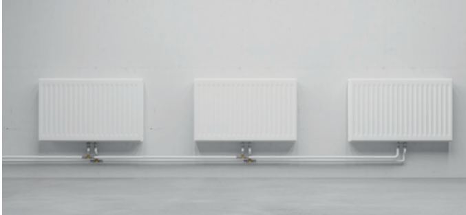
Fig. 47: Het klassieke verwarmingssysteem met 2 buizen.
