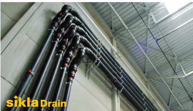
Hohe statische und dynamische Belastungen, die in einer Druckentwässerung entstehen, sind für das Schnellmontagesystem kein Problem. Sikla bietet ein komplettes Befestigungssystem von 40 – 315 mm.
