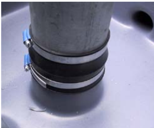
Kuva 5. Tiivistekumi 4" täyttöputken ympärillä
