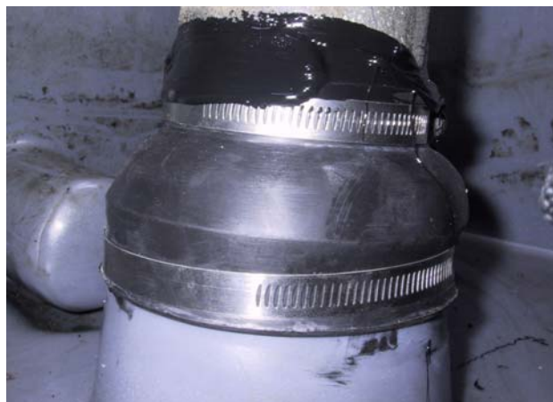
Kuva 4. Tiivistekumin asennus.
