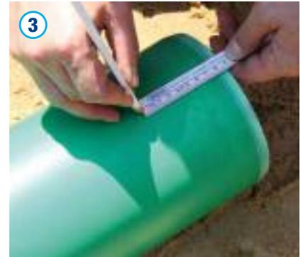
Die Einstecktiefe des Spitzendes in die Muffe ist mittels eines Zollstocks abzumessen und zu Kontrollzwecken am Spitzende des anzuschließenden Rohres anzuzeichnen. Auf diese Weise kann überprüft werden, ob das Spitzende vollständig eingeschoben wurde.
