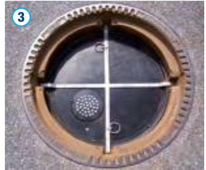
Der Einbau von Geruchsfiltersystemen ermöglicht eine Vermeidung von Geruchsbelästigungen aus Kanalschächten. Speziell im Bereich von stehendem oder sulfidhaltigem Abwasser kann der Einsatz von Geruchsfiltern ratsam sein. Wir empfehlen hierfür den Uni-AdSorber von Unitechnics. Der Vorteil dieses Geruchsfiltersystems
