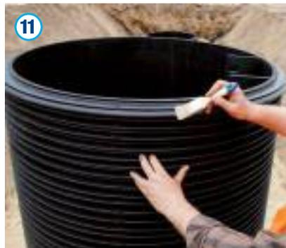
Der Einbau weiterer Schachtröhre ist analog zu Punkt 5 bis Punkt 8 durchzuführen. Für eine Verbindung mit dem Schachtkonus ist analog zu Punkt 5 bis Punkt 6 vorzugehen.
