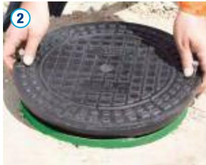
Dann sind die Außensechskantschrauben (M8) der Abdeckung mit einem Innensechskantschlüssel (13 mm) zunächst so weit zu lösen, dass die Abdeckung auf das Schachtröhrende aufgesetzt werden kann.
