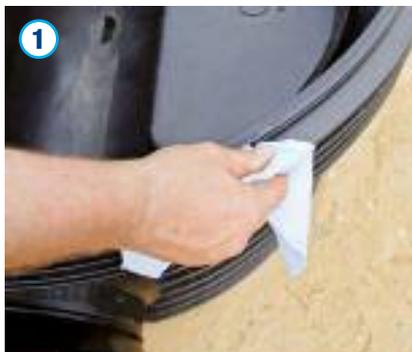
Vor dem Einbau der Schächte sind alle Bauteile auf Beschädigungen und Verunreinigungen zu überprüfen. Verunreinigte Dichtelemente und Schachtkomponenten sind zu säubern. Beschädigte Bauteile sind ggf. auszutauschen. Die Dichtelemente sind auf korrekten Sitz zu überprüfen.
