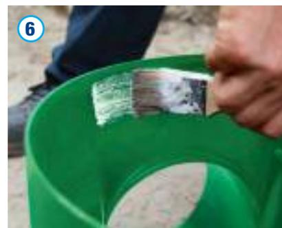
Bevor das Schachtrrohr auf den Schachtboden aufgesetzt werden kann, ist der Muffenbereich des Schachtbodens gleichmäßig umlaufend mit Gleitmittel zu versehen.
