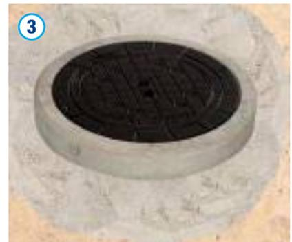
Der Schacht ist nun lagenweise gemäß DIN EN 1610 weiter zu verfüllen und zu verdichten. Gemäß Planungsvorgaben ist der Oberflächenaufbau z. B. für Asphalt oder Pflaster zu erstellen.
