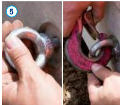
In die Hülsen sind passende Gewindeösen M 16 sicher einzuschrauben. Die Betonabdeckplatte ist dann mit einer geeigneten Kette an allen Ösen sicher einzuhängen.
