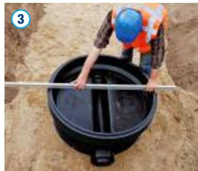
Der Schachtboden ist gemäß den Planungsvorgaben auszurichten und entsprechend dem erforderlichen Gefälle im Gerinne einzubetten. Bei Bedarf ist der Schachtboden in die Bettung einzulassen. Das Spitzende des anzuschließenden Rohres ist gemäß Herstellerangaben zu säubern, anzufasen und gleichmäßig mit Gleitmittel zu versehen.
