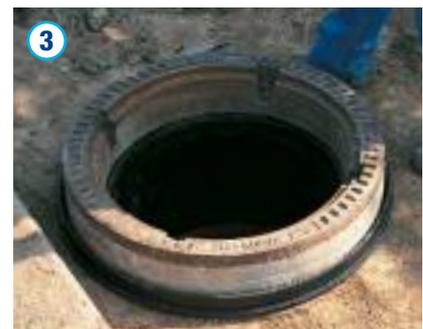
Zur Vermeidung von Punktlasten ist die Auflagefläche der Abdeckung ggf. mit einer Ausgleichsschicht aus Mörtel zu versehen. Die Abdeckung ist dann unter Beachtung des Adapterinnenmaßes D1 in den Teleskopadapter einzulegen und der Ringspalt zwischen Abdeckung und Teleskopadapter ggf. mit Vergussmörtel zu verfüllen, bevor die Oberfläche gemäß den Planungsvorgaben erstellt werden kann.
