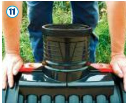
Beide Hebel sind synchron bis zum Einrasten herunterzudrücken, damit der Sattel nicht verkantet. Durch das Umlegen der Montagehebel wird der Kern nach oben gezogen und die integrierte Dichtung legt sich umlaufend dicht an die Rohrwand an. Es ist zu kontrollieren, ob sich die Dichtung gleichmäßig an das Hauptrohr angepresst hat.
