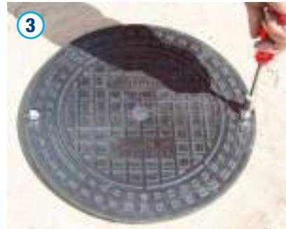
Die Außensechskantschrauben sind nach dem Aufsetzen der Abdeckung im Schachtröhre zu verschrauben. Hierbei ist die Abdeckung auf das Schachtröhre zu drücken oder zu fixieren.
