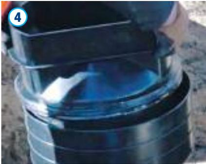
4 Vor dem Einstecken des Ablaufoberteils in den Straßenablaufgrundkörper ist die Dichtung umlaufend mit Gleitmittel einzustreichen. Die Steckverbindung ist ohne Verschmutzung von Hand herzustellen. Es ist auf die Einstecktiefenmarkierung zu achten.
