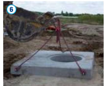
Die Betonabdeckplatte ist waagrecht auf das von einem ebenen Betonaufleger umgebene Schachtrohrende abzusetzen. Gemäß Vorgaben ist hierbei eine Setzungsfuge von min. 20 mm und max. 50 mm zu berücksichtigen. Für einen Lastabtrag in den umliegenden Boden ist bauseits Sorge zu tragen. Die Abdeckung ist abschließend unter Verwendung von Ausgleichsmörtel auf die Abdeckplatte zu setzen. Punktlasten und Hohlräume sind hierbei grundsätzlich zu vermeiden.
