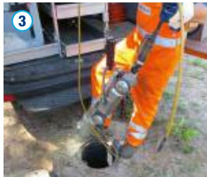
Zur Inspektion mittels TV-Befahrung ist die Sedimentationsanlage gemäß **Schritt 2** zu entleeren und zu reinigen. Anschließend wird mittels TV Kamera die Anlage durch den Ablaufschacht inspiziert. Die Inspektion sollte in Richtung des Zulaufschachtes erfolgen. Im Rahmen der Inspektion sollten alle Einbauteile sowie die Innenwandung auf Ablagerungen und/oder Beschädigungen hin untersucht und begutachtet werden.
