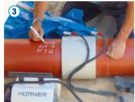
Das Formstück wird, ohne zu verkanten, auf das Rohr gesteckt. Hierbei ist die Einstecktiefe zu beachten. Die Schweißkontakte werden mit dem Schweißgerät verbunden und der Barcode eingelese, um die Schweißung zu starten. Die Schweißparameter werden neben dem Formteil auf dem Rohr festgehalten.
