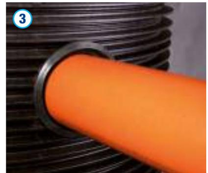
Das anzuschließende Rohr (z. B. KG, KG 2000 oder Acaro PP) ist mit dem angefasten Spitzende in die Anschlussdichtung einzuführen. Bei dem Anschluss-Stück DN/OD200 ist darauf zu achten, dass das Anschluss-Stück frei von Verunreinigungen ist und sich das Dichtelement an der dafür vorgesehenen Position befindet.
