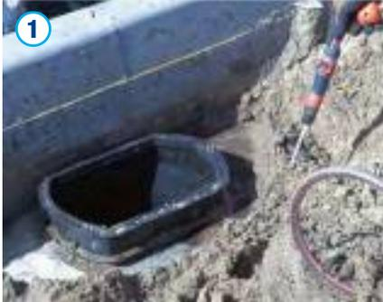
Zur Vermeidung von Hohlräumen und für eine optimale Verdichtung wird das Einschlämmen des Bodens im direkten Seitenbereich empfohlen. Für einen sicheren Lastabtrag ist ein geeignetes Auflager herzustellen. Das Auflager aus verdichtungsfähigem Material ist gemäß DIN EN 1610 bis zu einer Proctordichte von min. 95 % zu verdichten.
