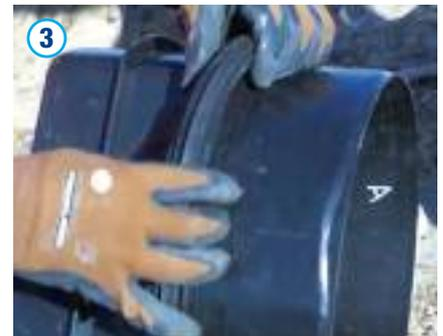
Das symmetrische Dichtelement ohne verdrehen oder überdehnen in das dafür vorgesehene Rippental des Ablaufoberteils einlegen. Je nach Gussaufsatz ist das Oberteil 300x500 oder 500x500 rund einzusetzen.
