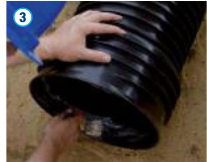
Das Gleitmittel ist gleichmäßig auf die Muffeninnenfläche aufzutragen, bevor das Spitzende mit eingelegerter Dichtung bis zum Anschlag in die Muffe eingeschoben werden kann. Ein Zurückziehen des Rohres ist nicht erforderlich. Geringe Richtungsänderungen sind durch eine Abwinkelung von max.  $0,5^\circ$  in der Muffe realisierbar. Dies entspricht 5 cm Auslenkung auf 5 m.
