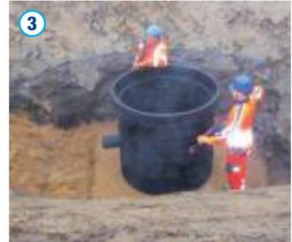
Der Schachtboden ist in den Graben abzulassen, gemäß den Planungsvorgaben zur Leitungsführung auszurichten und schließlich entsprechend dem erforderlichen Gefälle einzubetten. Hierbei ist auf den Höhenunterschied zwischen Bodenplatte und Rohranschluss zu achten.
