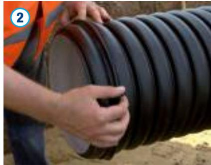
Das Spitzende inklusive Wellen sowie die Innenfläche der Muffe müssen sauber und frei von Beschädigungen sein. Andernfalls ist das Rohr zu reinigen oder ggf. auszutauschen. Der Dichtring ist im ersten Wellental einzulegen. Der ordnungsgemäße Sitz des Dichtrings am Rohrumfang ist zu überprüfen. Verdrehungen der Dichtung sind nicht zulässig.
