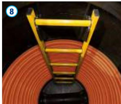
Der Konus ist gemäß der Steigleiterposition im Schachtrohr auszurichten, aufzusetzen und dabei die Leiter mittig so über die Aufhängung zu führen, dass diese an den Innenseiten der Steigleiter liegt.
