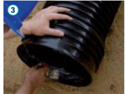
Das Gleitmittel ist gleichmäßig auf die Muffeninnenfläche aufzutragen, bevor das Spitzende mit eingelegerter Dichtung bis zum Anschlag in die Muffe eingeschoben werden kann. Ein Zurückziehen des Rohres ist nicht erforderlich. Geringe Richtungsänderungen sind durch eine Abwinkelung von max.  $0,5^\circ$  in der Muffe realisierbar. Dies entspricht 5 cm Auslenkung auf 5 m.
