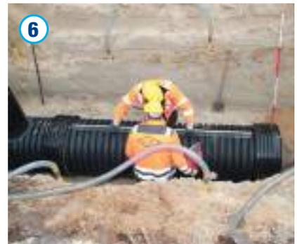
6 Die Sedimentationsanlage ist mithilfe einer Wasserwaage auszurichten und zu fixieren.
