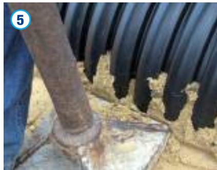
Die Bettung, Seitenverfüllung, Überdeckung und Hauptverfüllung sind gemäß DIN EN 1610 auszuführen. Die Seitenverfüllung ist insbesondere im Kämpferbereich besonders sorgfältig mit leichtem Verdichtungsgerät durchzuführen.
