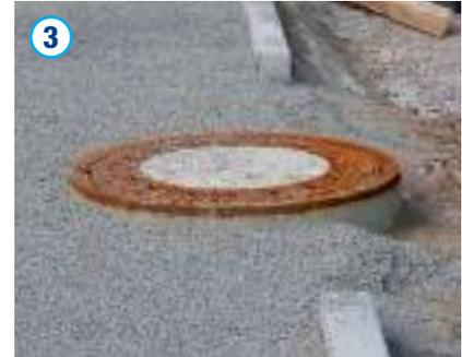
Die Abdeckung ist letztlich unter Verwendung von Ausgleichsmörtel (Estrichmörtel, gemäß DIN 4034) auf den Betonring zu setzen. Die Verlegung des Kunststoffauflagerings erfolgt analog zu voran ausgeführter Einbauanleitung. Anstelle eines Estrichmörtels ist hierbei jedoch ein Polymermörtel zu verwenden.
