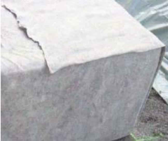
Sind alle Versickerungshohlkörper eingebaut, ist die Umhüllung der gesamten Rigole mit Vliesstoff (z. B. Wavin Vliesstoff PP Typ MVV 150) abzuschließen. Hierzu sind die seitlich gelagerten Überlängen des Vliesplanums über der Rigole zusammenzuschlagen.
