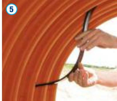
Zur Endmontage des Spannringes ist der in das Schachtrohr ragende Teil des Spannringes gemäß obiger Abbildung gewaltfrei zurück in das Welltal zu drücken. Nach der Montage des Spannringes sollte dieser umlaufend am Schachtrohr anliegen und fest im Wellental sitzen. Die Verschlusskappen der Steigleiterholme sind zu entfernen und später zum Sichern der Steigleiter wieder einzusetzen.
