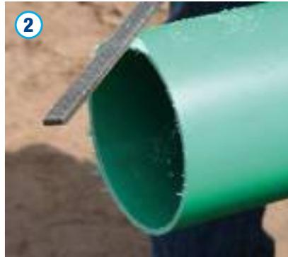
Grate und Unebenheiten sind mit einem geeigneten Werkzeug, wie beispielsweise einem Schaber, zu entfernen. Ferner ist das Rohr an der Schnittstelle wieder sorgfältig umlaufend z. B. mit einer groben Feile anzufassen.
