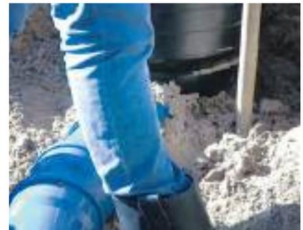
Nachdem der Straßenablauf abgeschlossen und ausgerichtet ist, kann der Grundkörper und die Anschlussleitung mit geeignetem Material verfüllt und von Hand oder leichtem Gerät bis zu einer Proctordichte von min. 95% verdichtet werden. Der Einsatz von Ortbeton ist nicht notwendig!
