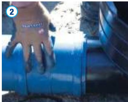
Das Spitzende des Straßenablaufgrundkörpers ist mit dem vorgesehenen Rohrsystem zu verbinden. Hierbei wird die Muffe des Rohrsystems auf das Spitzende DN/OD 160 geschoben. Die Verlegeanleitungen des Rohrherstellers sind zu berücksichtigen. Nach dem Herstellen des Rohranschlusses kann der Grundkörper in die gewünschte Richtung ausgerichtet werden.
