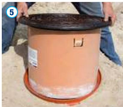
Durch das Teleskoprohr ist nun eine exakte Höhenanpassung entsprechend den Planungsvorgaben möglich. Hierbei ist auf eine Mindesteinstecktiefe von min. 100 mm im Schachtröhr zu achten. Der Schacht ist nun lagenweise (max. 30 cm) gemäß DIN EN 1610 weiter zu verfüllen und verdichten.
