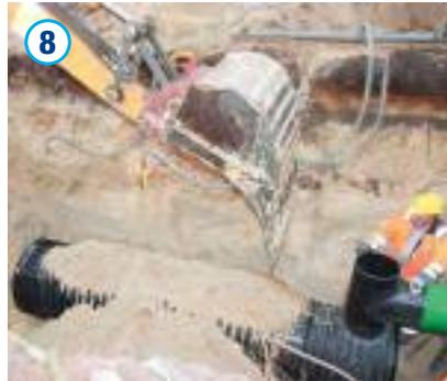
Die Seitenverfüllung, Überdeckung und Hauptverfüllung sind gemäß DIN EN 1610 auszuführen. Die Seitenverfüllung ist insbesondere im Kämpferbereich besonders sorgfältig mit leichtem Verdichtungsgerät durchzuführen. Achtung: Achten Sie darauf, dass kein Sand in die Sedimentationsanlage fällt.
