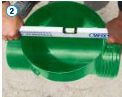
Der Schachtboden ist gemäß den Planungsvorgaben auszurichten. Hierbei ist der Schachtboden entsprechend dem erforderlichen Gefälle einzubetten. Zusätzlich ist ggf. darauf zu achten, dass die Schachtrohrmuffe senkrecht zur Rohrachse steht. Bei Bedarf kann der Schachtboden auch gemäß der Rohrauflegefläche bis zur Muffe in die Bettung eingelassen werden.
