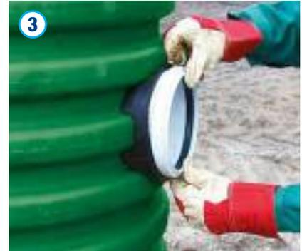
3 Anschließend ist das Anschluss-Stück DN/OD 110 bzw. DN/OD 160 in die Gummimanschette einzustecken. Das Spitzende des anzuschließenden Rohres ist gemäß Herstellerangaben anzufasern, mit Gleitmittel zu versehen und in das Anschluss-Stück einzustecken. Hierbei ist darauf zu achten, dass das Anschluss-Stück frei von Verunreinigungen ist.
