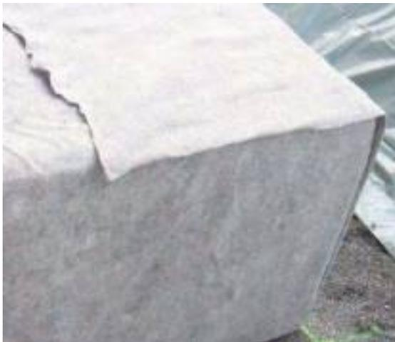
Sind alle Versickerungshohlkörper eingebaut, ist die Umhüllung der gesamten Rigole mit Vliesstoff (z. B. Wavin Vliesstoff PP Typ MVV 150) abzuschließen. Hierzu sind die seitlich gelagerten Überlängen des Vliesplans über der Rigole zusammenzuschlagen.
