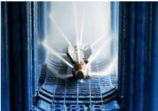
Bei extremen Ablagerungen kann das System mit Hilfe eines Hochdruckspülsystem gereinigt werden. Die Art und Wirksamkeit des Spülvorgangs ist abhängig vom Spülsystem und der Anzahl der Inspektions- und Reinigungsschächte.
