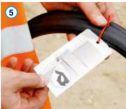
Zur Verbindung von Schachtboden und Schachtröhre ist ein Dichtring DN 1000 einzusetzen. Vor der Aufnahme des Dichtringes ist der Schachtboden gegebenenfalls zu reinigen. Der Dichtring ist dann gemäß der Anleitung auf dem Dichtringlabel des Dichtelementes DN 1000 zu montieren.
