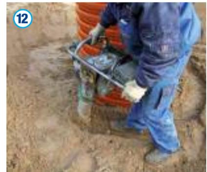
Abschließend ist der Schacht gemäß DIN EN 1610 in Lagen von max. 30cm zu verfüllen und mit entsprechendem Verdichtungsgerät zu verdichten. Die Proctordichte bei der Verdichtung muss in Gebieten ohne Verkehrslast mindestens 92%, in Gebieten mit PKW- oder Schwerlastverkehr mindestens 95% betragen.
