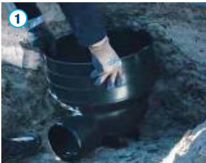
Der Straßenablaufgrundkörper kann direkt, ohne den Einsatz von Ortbeton, auf das Auflager gesetzt werden. Das Auflager ist gemäß DIN EN 1610 „Bettungstyp 1“ auszuführen. Bei ungeeigneten Böden ist eine verdichtete Sauberkeitsschicht gemäß DIN EN 1610 von min. 10 cm einzubringen.
