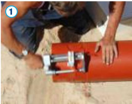
Das Spitzende des Acaro PP Rohres ist gemäß DVS 2207-11 vorzubereiten. Hierzu ist das Rohr rechtwinklig abzutrennen und mit einem geeigneten Schälgerät im Bereich der Schweißzone zu bearbeiten. Späne und sonstige Verunreinigungen sind zu entfernen.
