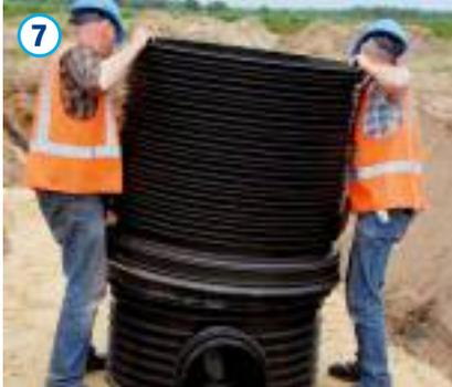
Danach ist das Schachtrohr mit integriertem Steiggang entsprechend dem Auftrittsbereich auszurichten und ohne Verkanten auf den Schachtboden aufzusetzen. Bei einer Montageunterstützung mit hydraulischem Gerät ist zum Schutz der Schachtbauteile ein Kantholz oder eine entsprechende Platte zentral zur Schachtachse aufzulegen.
