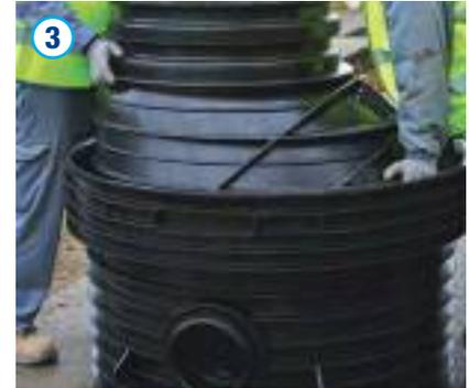
Der Konus ist gleichmäßig und ohne Verkanten in den Schachtboden zu setzen.
