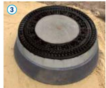
Die Abdeckung ist dann unter Verwendung von Polymerausgleichsmörtel auf den Auflagering abzusetzen. Die Verwendung von Ausgleichsringen ist analog möglich. Die Vorschriften und Richtlinien zum Straßenbau sind zu beachten. Für den EVZ-Wert unter dem Auflagering ist die ZTVE-StB 09 zu berücksichtigen.
