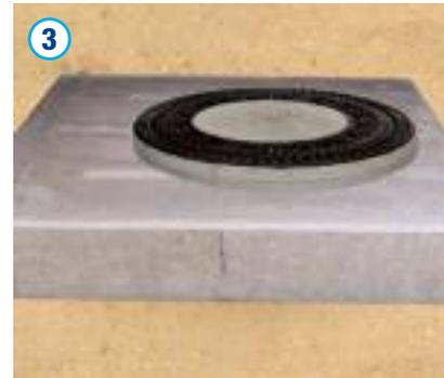
Der Schacht ist bis max. 200 mm unterhalb des Schachtrohrendes lagenweise gem. DIN EN 1610 zu verfüllen und zu verdichten. Um das noch freiliegende Schachtrohrende ist eine Schutzschalung (z. B. stabile Folie oder Dachpappe) anzubringen und gemäß Vorgaben ein Auflager aus Ortbeton C12/15 zu erstellen. Der Steiggang ist vor dem Aufsetzen der Betonabdeckplatte um 100 mm von oben einzukürzen.
