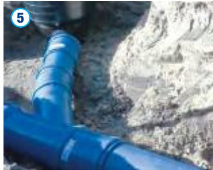
5 Ausrichten des Straßenablaufs und Anschluss an die Sammelleitung. Hierbei ist auf das vorgesehene Gefälle der Anschlussleitung zu achten, um Gegengefälle zu vermeiden.
