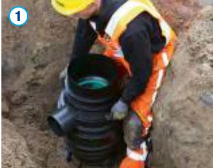
Der Tegra Straßenablauf mit Schlammfang kann direkt, ohne den Einsatz von Ortbeton, auf das vorbereitete und verdichtete Auflager gesetzt werden. Das Auflager ist gemäß DIN EN 1610 „Bettungstyp 1“ auszuführen. Bei ungeeigneten Böden ist eine verdichtete Sauberkeitsschicht gemäß DIN EN 1610 von min. 10 cm einzubringen.
