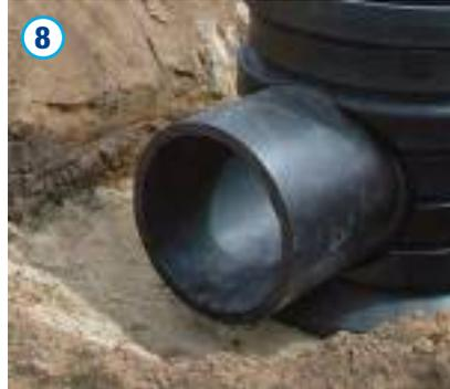
Je nach Ausführung sind die Rohranschlüsse herzustellen. Hierzu ist ggf. das Spitzende des anzuschließenden Rohres zu säubern, anzufasen und gleichmäßig mit Gleitmittel zu versehen oder für Schweißverbindungen das Rohrende zu schälen und mit PE-Reiniger frei von Rückständen vorzubereiten. Schweißverbindungen können entweder mittels Heizwendel- oder Spiegelstumpfschweißungen ausgeführt werden.
