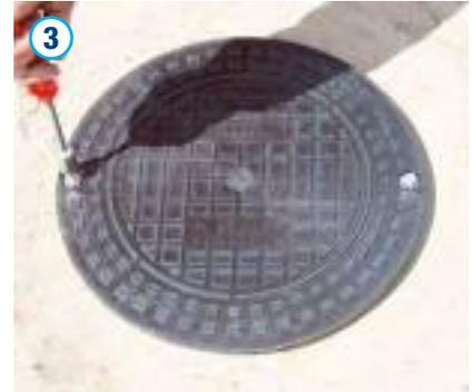
Die Außensechskantschrauben sind nach dem Aufsetzen der Abdeckung im Schachtrohr zu verschrauben. Hierbei ist die Abdeckung auf das Schachtrohr zu drücken oder zu fixieren.
