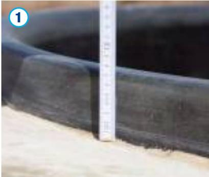
Der Schacht ist bis max. 75 mm unterhalb des Schachtrohrendes lagenweise gemäß DIN EN 1610 zu verfüllen und zu verdichten. Um das noch freiliegende Schachtrohrende ist eine Schutzschalung (z. B. stabile Folie oder Dachpappe) anzubringen und gemäß Vorgaben ein Auflager aus Ortbeton C12/15 zu erstellen.
