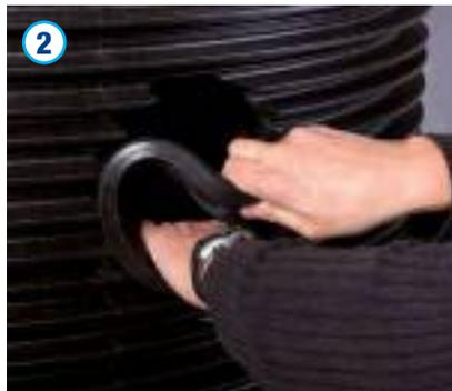
Vor dem Einlegen der Anschlussdichtung ist die Bohrung umlaufend zu entgraten und zu säubern. Die Anschlussdichtung (z. B. Forsheda F910) ist ohne Gleitmittel in die gebohrte Öffnung einzusetzen. Nach Montage der Anschlussdichtung ist diese an der Innenseite gleichmäßig mit Gleitmittel zu versehen.
