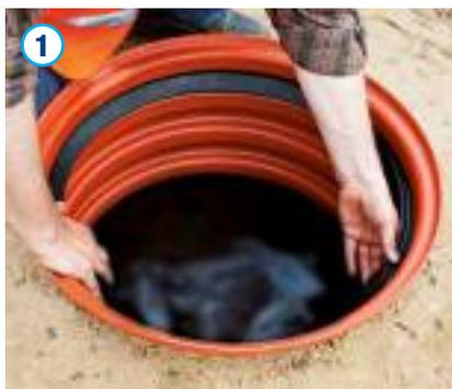
Gemäß DIN EN 124 ist die Kunststoffabdeckung A 15 DN600 aus PP ausschließlich für den begehbaren Bereich der Gruppe 1 einzusetzen. Für den Einsatz der Kunststoffabdeckung ist die entsprechende Dichtung im ersten Tal der Schachttinnenseite zu montieren. Die Dichtung ist für ein einfaches und sicheres Einstecken des Rahmens gleichmäßig mit Gleitmittel zu bestreichen.
