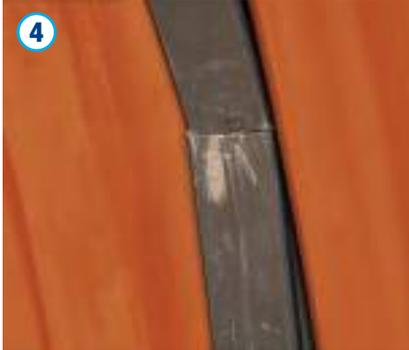
Der Spannring mit Steigleiterholm-aufnahmen ist im Schachtrohr zu installieren. Die Installation erfolgt im drittletzten Wellental am unteren Ende des Schachtrohres durch zunächst ein lockeres Einlegen des Spannringes, dessen Enden auf Stoß voreinander gesetzt werden müssen.
