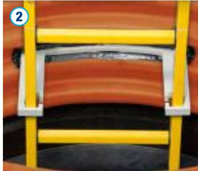
Beim Einsetzen der Steigleiter ist darauf zu achten, dass die Steigleiter mittig durch die Aufnahme im Schachtrohr geführt wird und beide Seitenholme die Steigleiter sauber umschließen, so dass die Leiter frei hindurchgleiten kann. Ein Verkanten ist in jedem Fall zu vermeiden.
