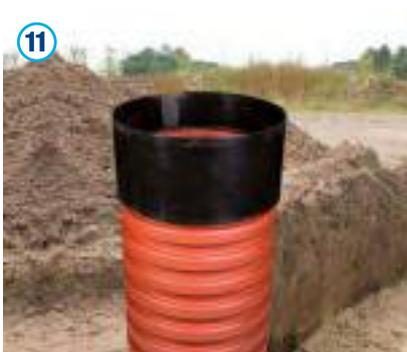
Für eine ggf. erforderliche Verlängerung des Schachtröhres kann eine Doppelmuffe verwendet werden. Hierbei ist zur Verbindungsherstellung analog zu Punkt 9 und 10 zu verfahren. Die Doppelmuffe ist auf das bereits im Schachtboden befindliche Schachtrohr aufzustecken, bevor das zur Verlängerung nötige Schachtrohr in die Doppelmuffe eingesteckt werden kann.
