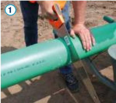
Die Verlegung von KG 2000 ist gemäß DIN EN 1610 auszuführen. KG 2000 Rohre können bei Bedarf bauseits auf die erforderliche Länge gekürzt werden. Hierzu ist das Rohr mit einer feinzahnigen Säge senkrecht abzulängen. Formteile dürfen nicht gekürzt werden.
