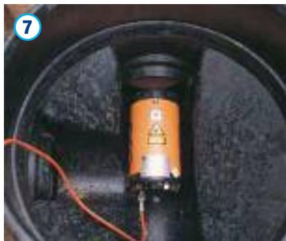
Zur Ausrichtung der Leitungsführung gemäß Planungsvorgaben kann ein Laser in den Schachtboden eingesetzt werden. Die herstellerspezifischen Angaben sowohl vom Laser als auch von den Rohren sind hierbei zu beachten.
