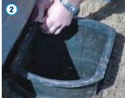
Zur lastentkoppelten Abdichtung der Verbindung zwischen Straßenablauf und Kunststofflastaufnahmering, das Dichtelement ohne den Einsatz von Gleitmittel aufziehen.
