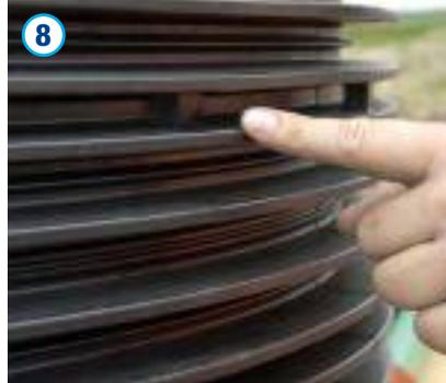
Das korrekte Ausrichten der einzelnen Schachtelemente kann neben einer Orientierung an dem Steiggang auch anhand von außenliegenden Markierungen (gemäß Abbildung) vorgenommen oder überprüft werden.
