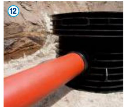
Bei einem Anschluss an Wavin Schächte wie beispielsweise das Tegra Schachtsystem werden diese direkt mit vollwertigen Kugelgelenkmuffen ausgeliefert. Ein Rohranschluss ist dann mühelos analog zu der Herstellung von Rohrverbindungen durchzuführen. Andere Schachtsysteme müssen z. B. durch entsprechende Schachtfutter eine Anschlussmöglichkeit für glattwandige, genormte Rohrsysteme bieten.
