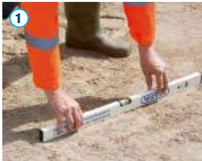
Die Aufstandsfläche des Schachtbodens ist gemäß DIN EN 1610 „Bettung Typ 1“ auszuführen. Zur Vermeidung von Punktlasten oder Hohlräumen ist die Aufstandsfläche entsprechend der Schachtbodenunterseite vorzuformen oder bei der Verfüllung auf eine entsprechende Unterfüllung zu achten. Alle Komponenten sind vor dem Einbau zu überprüfen.
