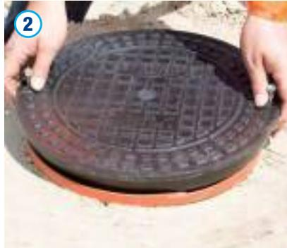
Dann sind die Außensechskantschrauben (M 8) der Abdeckung mit einem Innensechskantschlüssel (13 mm) zunächst so weit zu lösen, dass die Abdeckung auf das Schachtröhrende aufgesetzt werden kann.
