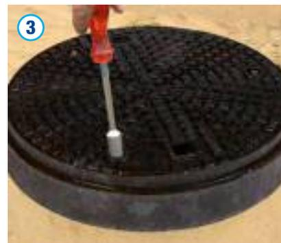
Zum Öffnen des Deckels sind die Außensechskantschrauben M 25 mit einem Innensechskantschlüssel (25 mm) zu lösen. Beim Schließen des Deckels ist darauf zu achten, dass die enthaltene Dichtung richtig positioniert wird, um eine Tagwasserdichtheit wieder herzustellen.
