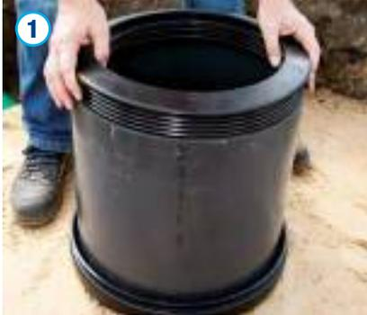
Das Schachtrohr ist je nach Einbautiefe ggf. zu kürzen, zu entgraten und die Teleskopmanschette ggf. zu reinigen. Die Manschette ist dann bis zum Anschlag in das Schachtrohr einzustecken. Hierbei ist kein Gleitmittel zu verwenden. Das angefastete Teleskoprohr der Teleskopabdeckung ist dann gleichmäßig mit Gleitmittel zu versehen und in die Manschette einzuführen.
