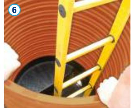
Nach der Spannringmontage ist die Steigleiter durch die Steigleiterholm-aufnahmen zu schieben. Die Holmaufnahmen sollen zwischen der letzten und vorletzten Sprosse liegen, dann sind sie mit den Verschlusskappen wieder zu verschließen. Das Schachtrohr inklusive einseitig fixierter Leiter ist analog Schritt 5–10 der Einbauanleitung auf den Schachtboden aufzusetzen.
