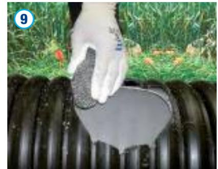
Die Bohrung ist mit z. B. feinem Schleifpapier (beiliegend) zu entgraten. Ein Messer zum Entgraten ist nicht zulässig, da dies die Abdichtungsfläche beschädigen könnte und die Dichtigkeit dann nicht mehr gewährleistet werden kann. Es ist darauf zu achten, dass die Dichtfläche frei von Unebenheiten ist und der Durchmesser nicht vergrößert wird.
