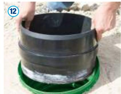
Bei Bedarf können Schachtrohre auch verlängert werden. Hierzu ist eine entsprechende Schachtrohrverlängerung einzusetzen. Diese ist beidseitig am Spitzende mit Gleitmittel zu versehen. Die Schachtrohrenden zur Verlängerung sind jeweils im letzten Wellental der Schachtrohrrinnenseite mit einem Dichtelement zu versehen. Dann können die Komponenten zusammengesteckt werden.
