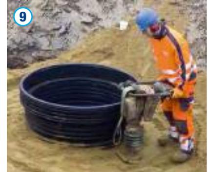
Der Schacht ist gemäß DIN EN 1610 in Lagen von max. 30cm zu verfüllen und mit entsprechendem Verdichtungsgerät zu verdichten. Die Proctordichte bei der Verdichtung muss in Gebieten ohne Verkehrslast mindesten 95 %, in Gebieten mit PKW- oder Schwerlastverkehr mindesten 98 % betragen.
