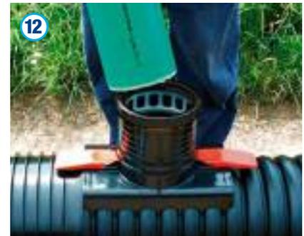
Nach der Montage des Sattels ist das anzuschließende KG oder KG 2000 Rohr in den Sattel einzustecken. Hierfür ist das Spitzende des Rohres anzufassen, zu entgraten und gleichmäßig mit Gleitmittel zu versehen.
