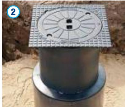
Durch das Teleskoprohr ist nun eine exakte Höhenanpassung entsprechend den Planungsvorgaben möglich. Hierbei ist auf eine Mindesteinstecktiefe des Teleskoprohres in der Teleskopmanschette von min. 100 mm zu achten. Der Schacht ist nun lagenweise (max. 30 cm) gemäß DIN EN 1610 weiter zu verfüllen und zu verdichten.
