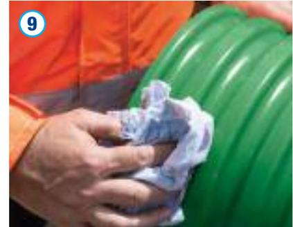
Ferner ist das Schachtrohr für die Aufnahme der Dichtung gegebenenfalls zu säubern.
