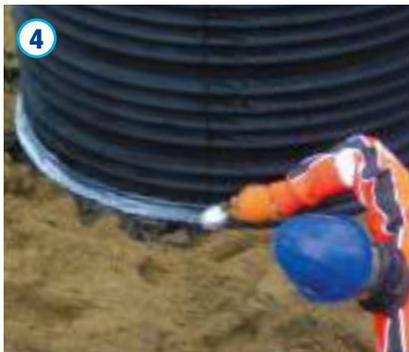
Bevor das Schachtrrohr auf den Schachtboden aufgesetzt werden kann, sind die Dichtelemente nochmals auf ihren korrekten Sitz zu überprüfen und alle Dichtflächen ggf. zu reinigen. Alle Dichtungen und Dichtflächen sind dann gleichmäßig und umlaufend mit Gleitmittel zu versehen.
