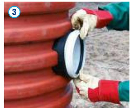
Anschließend ist das Anschluss-Stück DN/OD 160 in die Gummianschette einzustecken. Das Spitzende des anzuschließenden Rohres ist gemäß Herstellerangaben anzufasen, mit Gleitmittel zu versehen und in das Anschluss-Stück einzustecken. Hierbei ist darauf zu achten, dass das Anschluss-Stück frei von Verunreinigungen ist.
