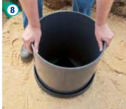
Das angefastete Ende des Schachtrohres ist bis zum Anschlag (Markierung) in den Schachtboden einzustecken. Die Baugrube ist lagenweise (30 cm) gemäß DIN EN 1610 weiter zu verfüllen und mit leichtem Verdichtungsgerät zu verdichten.
