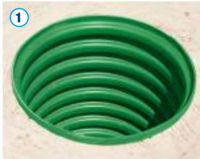
Der Schacht ist nun lagenweise gemäß DIN EN 1610 zu verfüllen und zu verdichten und der Oberflächenaufbau gemäß Planungsvorgaben herzustellen. Für die Kunststoffabdeckung A 15 aus PP gilt hierbei gemäß DIN EN 124, dass diese ausschließlich für den begehbaren Bereich der Gruppe 1 einzusetzen ist.
