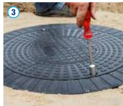
Beim Einsetzen der Inspektionsöffnung sind die Außensechskantschrauben M8 mit einem Innensechskantschlüssel (13 mm) in die dafür vorgesehenen Bohrungen wieder einzuschrauben. Die entsprechenden Aussparungen für die Bohrlöcher im Rahmen sind hierbei zu beachten. Die Oberfläche kann abschließend gemäß den Planungsvorgaben erstellt werden.
