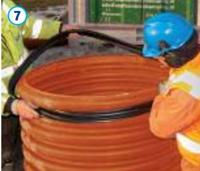
Zur Verbindung von Schachtrohr und Schachtboden, sowie Schachtrohr und Schachtkonus sind jeweils im gesäuberten, letzten Wellental an den Enden des Schachtrohres die Dichtungen wie in der Abbildung dargestellt einzulegen. Für die Installation des Dichtringes ist das jeweilige Label am Dichtring zu beachten.
