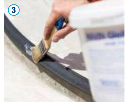
Die Dichtung ist dann, ebenso wie die Dichtfläche auf der Schachtrohrrinnenseite, gleichmäßig und umlaufend mit Gleitmittel zu versehen.
