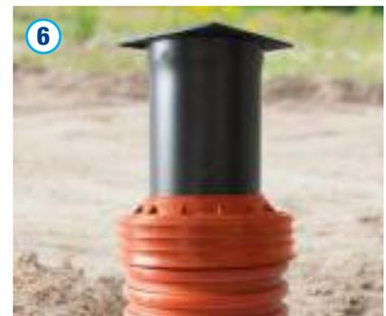
Das angefastete Rohr der Teleskopabdeckung ist ebenfalls zu reinigen und in die Teleskopmanschette zu stecken. Die Mindesteinstecktiefe beträgt 100 mm. Entsprechend den Planungsvorgaben ist die Höhe zu justieren und das Auflager herzustellen. Es kann sowohl ein Betonaufleger aus Ortbeton (C12/15) oder der Kunststoffauflagering eingesetzt werden.
