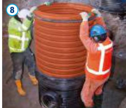
Danach ist das Schachtrohr ohne Verkanten in die Schachtbodenmuffe einzusetzen. Bei einer hydraulischen Montageunterstützung ist zum Schutz der Schachtbauteile ein Kantholz oder eine entsprechende Platte zentral zur Schachtachse aufzulegen. Bei Schächten mit Steigleiter ist ggf. auf eine korrekte Ausrichtung der Steigleitenaufnahme zu achten.
