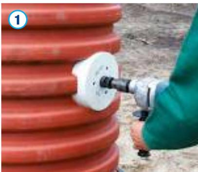
Mit einem Kronenbohrer  $\varnothing 127$  mm (Art. Nr. 4025428) bzw.  $\varnothing 177$  mm (Art. Nr. 4025429) ist zunächst ein Loch an der gewünschten Stelle in das Schachtrohr zu bohren. Die Bohrung ist abschließend zu entgraten und gegebenenfalls zu säubern.
