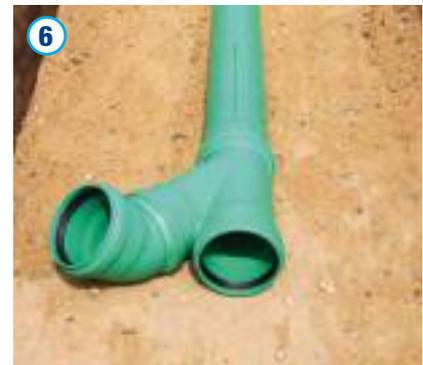
Geringe Richtungsänderungen sind durch eine Abwinkelung von max.  $0,5^\circ$  in der Muffe realisierbar. Dies entspricht 5 cm Auslenkung auf 5 m. Die Lage des Rohres ist zu überprüfen und nach Herstellung der Verbindung gegebenenfalls entsprechend zu korrigieren. Für den Übergang auf alternative Rohrleitungen sind entsprechende Formteile aus dem Lieferprogramm zu verwenden.
