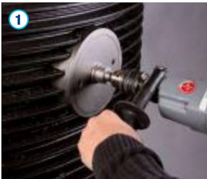
Mit einem Kronenbohrer ist zunächst ein Loch an der gewünschten Stelle in das Tegra 1000 PE Schachtrohr zu bohren. Der Durchmesser des Kronenbohrers ist dabei entsprechend der anzuschließenden Rohrleitung und gemäß Wavin Tegra 1000 PE Lieferprogramm zu wählen.
