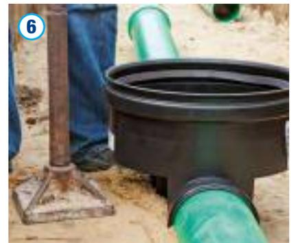
Der Schachtboden und die angeschlossenen Rohre sind gemäß DIN EN 1610 mit Sand, Kies oder sandigem Kies (Größtkorn 20 mm) zu verfüllen. Hierbei ist darauf zu achten, dass der Schachtboden lagenweise (max. 30 cm) von allen Seiten verfüllt und mit leichtem Verdichtungsgerät verdichtet wird. Es ist eine Proctor-dichte von  $D_{pr} \geq 97\%$  zu erreichen.
