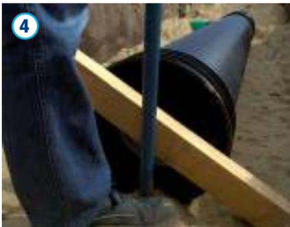
Rohre kleiner Nennweiten sind leicht von Hand zusammenzuschieben; für größere Nennweiten sind ggf. geeignete Hilfsmittel zu verwenden. Ein Zusammenschieben mit z. B. einem Baggerlöffel ist aufgrund unkontrollierter Kraftentfaltung und Rohrbeschädigungen nicht zulässig. Die Lage des Rohres ist zu überprüfen und nach Herstellen der Verbindung evtl. entsprechend zu korrigieren.
