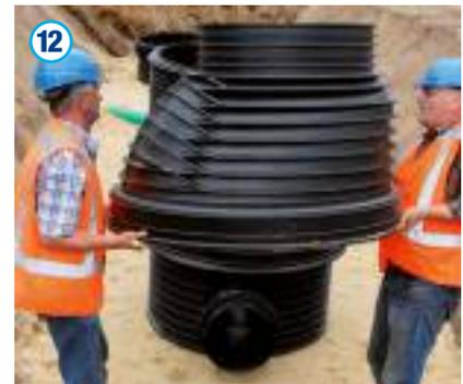
Der Schachtkonus ist letztlich entsprechend Abbildung 8 auszurichten und auf das Schachtrohr aufzusetzen. Bei einer hydraulischen Montageunterstützung ist analog zu Punkt 7 vorzugehen. Bei Bedarf kann der Schachtkonus um bis zu 80 mm gekürzt werden. Danach ist der Schacht gemäß DIN EN 1610 lagenweise (max. 30 cm) mit leichtem Gerät zu verfüllen und zu verdichten (Proctordichte  $\geq 97\%$ ).
