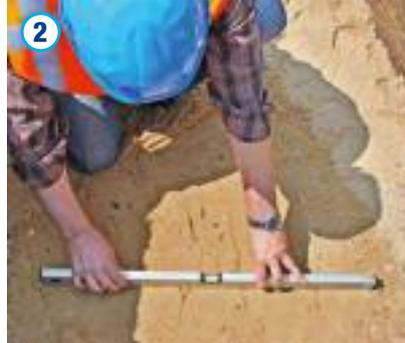
Die Aufstandsfläche des Schachtbodens ist gemäß DIN EN 1610 „Bettung Typ 1“ (vgl. Seite 489) auszuführen. Hierbei ist das Auflager für den Schachtboden durch eine min. 10 cm dicke, verdichtete Sauberkeitsschicht zu bilden.
