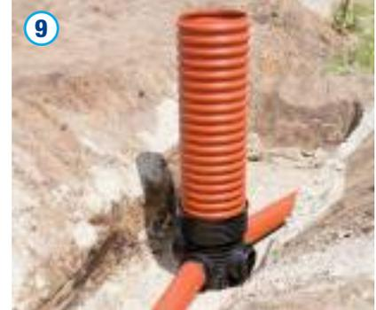
Das Spitzende des anzuschließenden Rohres ist gemäß Herstellerangaben zu säubern, anzufasen und mit Gleitmittel zu versehen. Nach dem Einstecken ist die Rohrführung entsprechend den Planungsvorgaben auszurichten. Hierzu kann das Rohr durch integrierte Kugelgelenke stufenlos in die erforderliche Richtung abgewinkelt werden. Es lassen sich sowohl Richtungsänderungen im Bereich von 15° als auch Gefälle von bis zu 13 % realisieren.
