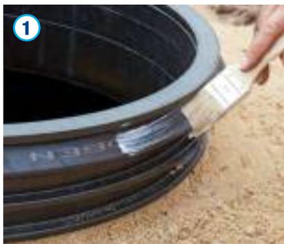
Gemäß DIN EN 124 ist die Abdeckung B 125 ausschließlich für den befahrbaren Bereich der Gruppe 2 einzusetzen. Für den Einsatz der Abdeckung B 125 ist die entsprechende Dichtung DN625 mit der Schrift nach oben zwischen der ersten und zweiten Rippe am Konus einzulegen. Die Dichtung und die Dichtfläche des Auflageringes sind gleichmäßig mit Gleitmittel zu versehen.
