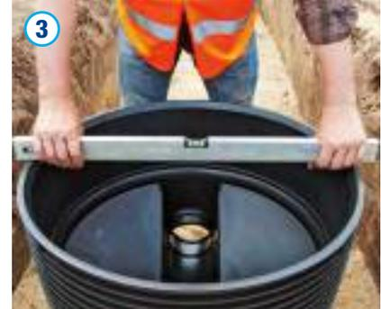
Der Schachtboden ist gemäß den Planungsvorgaben auszurichten. Hierbei ist der Schachtboden entsprechend dem erforderlichen Gefälle einzubetten. Zusätzlich ist ggf. darauf zu achten, dass die Schachtrohrmuffe senkrecht zur Rohrachse steht.
