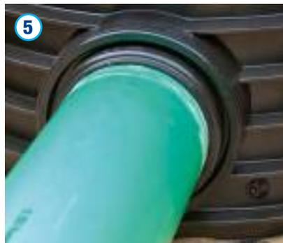
Das Spitzende des anzuschließenden Rohres ist gegebenenfalls zu säubern und gemäß Herstelleranweisung anzufasen, zu entgraten und gleichmäßig mit Gleitmittel zu versehen. Je nach Verlegesituation ist dann der Schachtboden auf das Spitzende des Rohres zu schieben oder das Rohr bis zum Anschlag in den Schachtboden einzustecken.
