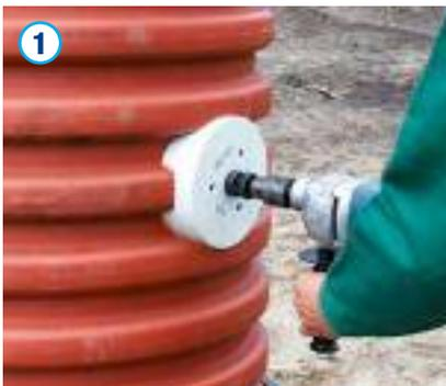
Mit einem Kronenbohrer  $\varnothing 177$  mm (Art. Nr. 4025429) ist zunächst ein Loch an der gewünschten Stelle in das Schachtrohr zu bohren. Die Bohrung ist abschließend zu entgraten und gegebenenfalls zu säubern.
