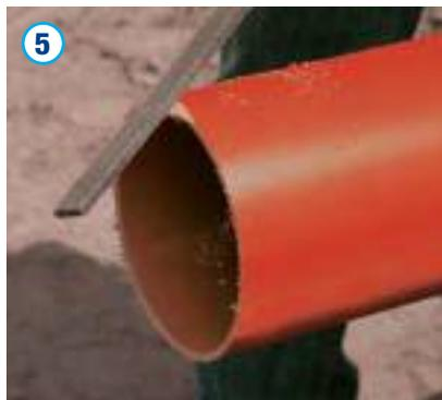
Ferner ist das Rohr an der Schnittstelle wieder sorgfältig umlaufend z. B. mit einer groben Feile anzufasen. Die Einstecktiefe des Spitzendes in die Muffe ist anhand einer Einstecktiefenmarkierung nach dem Ablängen mittels eines Zollstocks abzumessen und zu Kontrollzwecken am Spitzende des anzuschließenden Rohres anzuzeichnen. Auf diese Weise kann überprüft werden, ob das Spitzende vollständig eingeschoben wurde.
