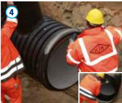
4 Zum Verbinden von Zulauf- und Erweiterungsmodul ist auf dem Spitzende des Zulaufmoduls der Dichtring im ersten Wellental einzulegen und Gleitmittel gleichmäßig aufzutragen.
