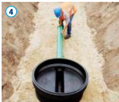
Je nach Verlegesituation ist der Schachtboden auf das Spitzende des Rohres zu schieben, oder das Rohr bis zum Anschlag in den Schachtboden einzustecken. Die Rohrführung ist dann gemäß den Planungsvorgaben auszurichten. Bei einer Ausführung mit Kugelgelenken ist hierbei sowohl eine stufenlose Richtungsänderung im Bereich von 15° als auch ein Gefälle von bis zu 13 % realisierbar.
