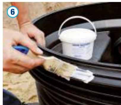
Das Dichtelement ist zwischen der ersten und zweiten Rippe des Schachtbodens anzubringen. Hierbei ist auf die korrekte Richtung und den richtigen Sitz mittig zwischen den Rippen zu achten. Vor dem Verbinden der einzelnen Elemente ist der Dichtring DN 1000 gleichmäßig mit Gleitmittel zu versehen.
