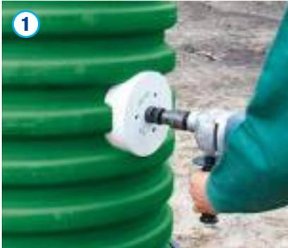
1 Mit einem Kronenbohrer  $\varnothing 127$  mm (Art. Nr. 4025428) bzw.  $\varnothing 177$  mm (Art. Nr. 4025429) ist zunächst ein Loch an der gewünschten Stelle in das Schachtrohr zu bohren. Die Bohrung ist abschließend zu entgraten und gegebenenfalls zu säubern.
