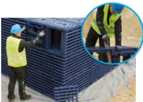
Offene Stellen können mit einer halben Seitenplatte verschlossen werden. Die Seitenplatte ist mithilfe einer Säge mittig zwischen dem Führungs-Doppelsteg in zwei Teile zu sägen.
