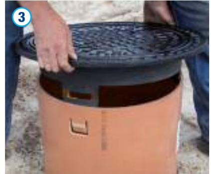
Die Gussabdeckung ist schließlich in das Teleskoprohr einzusetzen. Hierzu sind die drei Aussparungen so auszurichten, dass die Stege in die Abdeckung einrasten können.
