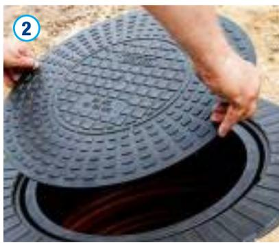
Der Abdeckungsrahmen ist in das Schachtrohr zu setzen, in der Höhe auszurichten (vgl. Einbaumatrix Seite 93 f.) und gemäß DIN EN 1610 anzufüllen und zu verdichten. Zum Herausnehmen der Inspektionsöffnung (des Deckel) können die Außen-sechskantschrauben M8 mit einem Innensechskantschlüssel (13 mm) gelöst werden.
