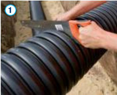
Wavin X-Stream Rohre können baueits auf die erforderliche Baulänge gekürzt werden. Hierzu ist das Rohr mit einer feinzahnigen Säge senkrecht zwischen zwei Wellen abzulängen. Grate und Unebenheiten sind mit einem geeigneten Werkzeug, z. B. grober Feile oder Schaber, zu entfernen. Ein Anfasen des Rohres ist nicht erforderlich. Formstücke dürfen nicht gekürzt werden.
