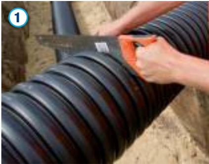
Wavin X-Stream Rohre können bauseits auf die erforderliche Baulänge gekürzt werden. Hierzu ist das Rohr mit einer feinzahnigen Säge senkrecht zwischen zwei Wellen abzulängen. Grate und Unebenheiten sind mit einem geeigneten Werkzeug, z. B. grober Feile oder Schaber, zu entfernen. Ein Anfasen des Rohres ist nicht erforderlich. Formstücke dürfen nicht gekürzt werden.
