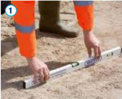
Die Verlegung von Acaro PP SN 12 ist gemäß DIN EN 1610 auszuführen. Hierzu ist ein Auflager aus Rundkorn oder Brechsand plan herzustellen. Für Rundkorn gilt in Abhängigkeit von der Rohrenweite eine maximale Korngröße von 22 mm bis DN/OD 200 und max. 40 mm bis DN/OD 500. Gebrochene Baustoffe haben eine Korngröße von 11 mm nicht zu überschreiten.
