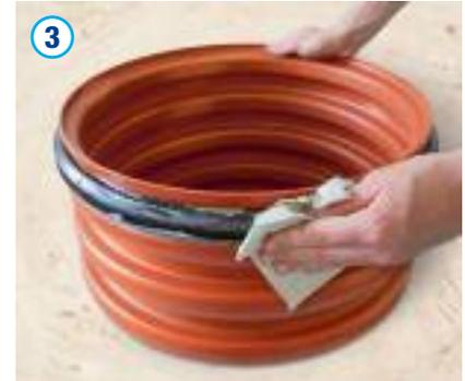
Sowohl der Dichtring als auch die Teleskopmanschette sind vor der Montage zu reinigen und auf Beschädigungen zu überprüfen. Beschädigte Bauteile dürfen nicht eingebaut werden und sind auszutauschen. Der Dichtring und die Manschette sind gleichmäßig mit Gleitmittel zu versehen.
