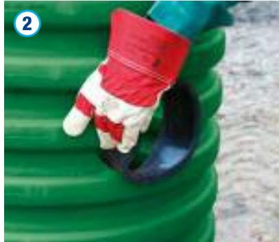
2 Daraufhin ist die Gummimanschette des Tegra 600 Anschluss-Stücks aus PP zunächst ohne Gleitmittel in die gebohrte Öffnung einzulegen. Erst nach erfolgreicher Montage der Gummimanschette ist diese an der Innenseite gleichmäßig mit Gleitmittel zu versehen. Es ist darauf zu achten, dass das Dichtelement an der dafür vorgesehenen Position verbleibt.
