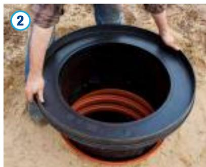
Der Adapter ist mit dem Spitzende in das Schachtrohr einzuschieben und gemäß Planungsvorgaben auszurichten. Hierbei muss das Teleskoprohr min. 15mm im Schachtrohr verbleiben. Zwischen Teleskopadapter und Schachtrohr ist eine Setzungsfuge von 20mm einzuhalten. Die Vorschriften und Richtlinien zum Straßenbau sind zu beachten und der EVZ-Wert unter dem Teleskopadapter muss der ZTVE-StB 09 entsprechen.
