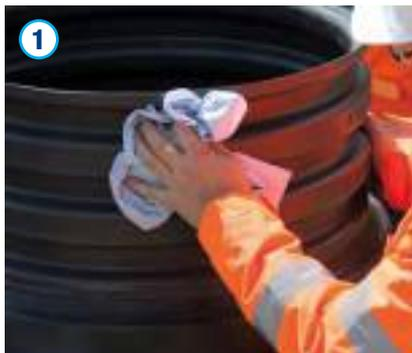
Vor der Montage der Abdeckung ist der Bereich der Dichtfläche auf Beschädigungen zu prüfen und zu reinigen, ggf. sind die Bauteile auszutauschen. Für das Auflager ist eine vollflächige Feinsand- bzw. Splittschicht aufzubringen und zu verdichten (vgl. Montage mit Teleskopadapter). Die Vorschriften und Richtlinien des Straßenbaus sind zu beachten. Für den EVZ-Wert unter der Abdeckung ist die ZTVE-StB 09 zu berücksichtigen.
