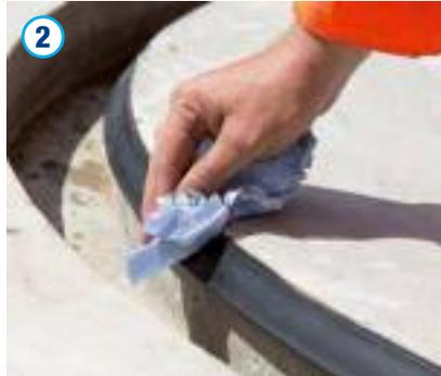
Die Dichtung der Betonabdeckplatte ist zu reinigen, auf Unversehrtheit und korrekten Sitz zu überprüfen. Die Dichtflächen auf der Schachtrohrrinnenseite sind gleichermaßen zu reinigen und auf Beschädigungen zu überprüfen.
