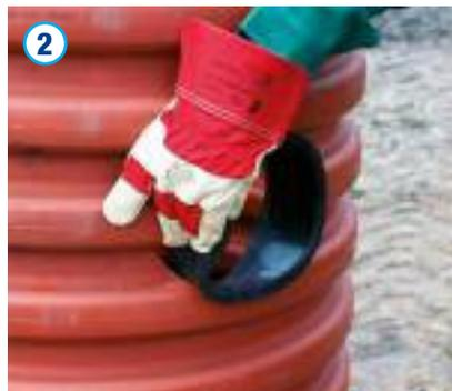
Daraufhin ist die Gummianschette des Tegra 600 Anschluss-Stücks aus PP zunächst ohne Gleitmittel in die gebohrte Öffnung einzulegen. Erst nach erfolgreicher Montage der Gummianschette ist diese an der Innenseite gleichmäßig mit Gleitmittel zu versehen. Es ist darauf zu achten, dass das Dichtelement an der dafür vorgesehenen Position verbleibt.
