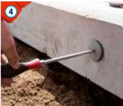
Die grauen Schutzkappen an den Außenkanten der Betonabdeckplatte sind mit einem geeigneten Schraubenzieher herauszuschrauben, um die M 16 Gewindehülsen freizulegen.
