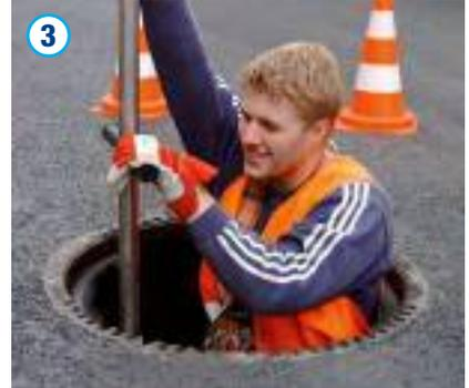
Gemäß der Gemeindeunfallversicherung (GUV 7.4 §5, Abs. 11, etc.) müssen für Einstiegsstellen mit ortsfest montierten Steigleitern in abwassertechnischen Anlagen und somit in Versorgungsschächten geeignete Haltevorrichtungen vorhanden sein. Eine Kombination aus fest montierbaren Edelstahlführungshülsen und mobilen Haltestangen
