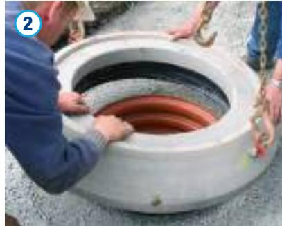
Der Auflagering ist ggf. unter Verwendung von 3 Gewindeösen M 12 einzuhängen und auf das Auflager abzusetzen. Der Auflagering kann dann z. B. mit Hilfe eines Kantholzes in die gewünschte Position gebracht werden. Hierbei ist darauf zu achten, dass der Auflagering nicht direkt auf dem Schachtrohrende aufliegt, sondern eine Setzungsfuge von min. 20mm eingehalten wird.
