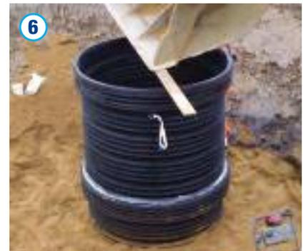
Bei einer Montageunterstützung mit hydraulischem Gerät ist zum Schutz der Schachtbauteile ein Kantholz oder eine entsprechende Platte zentral zur Schachtachse aufzulegen. Eine Bauteilüberlastung ist in jedem Fall auszuschließen.
