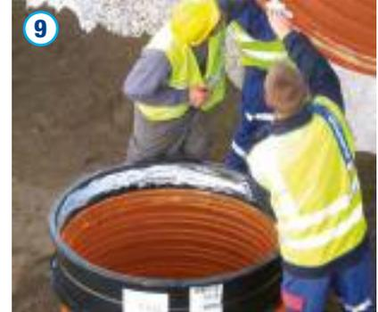
Zur Verlängerung von Tegra 1000 PP Schachtröhren kann ggf. eine Schachtrohrverlängerung eingesetzt werden. Die Verbindung zwischen Schachtrohrverlängerung und Schachtrohr hat analog zur Verbindung Schachtboden – Schachtrohr zu erfolgen.
