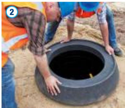
Der Auflagering ist schließlich auf das Auflager aufzusetzen. Bei Verwendung des Betonauflegerings ist dieser mit 3 geeigneten Gewindeösen M12 zu versehen, daran einzuhängen und auf den Konus abzusetzen. Hierbei kann eine Setzungsfuge von max. 50 mm realisiert werden. Punktlasten und Hohlräume sind grundsätzlich zu vermeiden!
