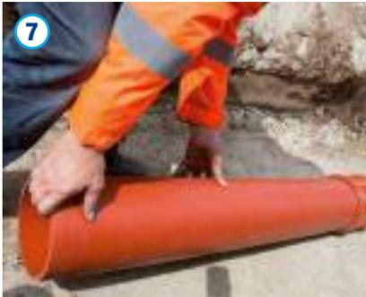
Rohre kleiner Nennweiten sind dann leicht von Hand zusammenschieben. Hierbei sind zudem geringe Richtungsänderungen durch eine Abwinkelung von max.  $0,5^\circ$  in der Muffe realisierbar. Dies entspricht 5 cm Auslenkung auf 5 m. Die Lage des Rohres ist zu überprüfen und nach Herstellung der Verbindung gegebenenfalls entsprechend zu korrigieren.
