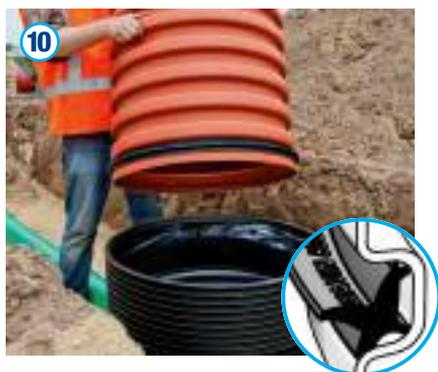
Die Schachtrohrmuffe des Schachtbodens ist in der Innenseite gleichmäßig mit Gleitmittel zu versehen. Das Schachtrohr mit eingelegter Dichtung ist auf den Schachtboden zu setzen und bis zum Anschlag einzustecken.
