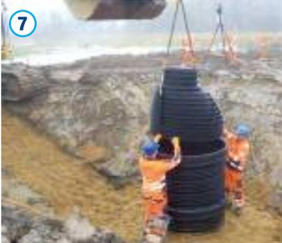
Der Schachtkonus ist abschließend analog zu den Schachtröhren auszurichten und ohne Verkanten aufzusetzen. Hierbei ist darauf zu achten, dass die Steigangausrichtung eingehalten wird. Bei einer Montageunterstützung mit hydraulischem Gerät (Bagger o. ä.) ist auch hier zum Schutz der Schachtbauteile ein Kantholz oder eine entsprechende Platte zentral zur Schachtachse aufzulegen.
