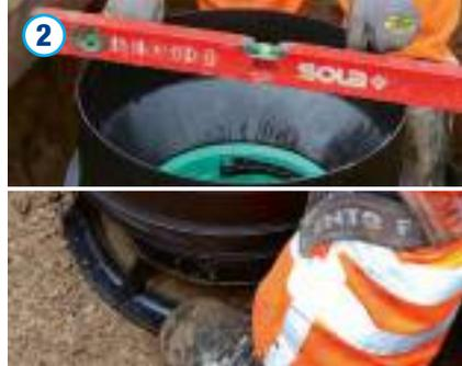
Der Straßenablauf ist entsprechend den Planungsvorgaben auszurichten. Hierbei ist sowohl auf die vorgegebene Einbautiefe als auch auf den Rohranschlussstutzen zu achten. Hierzu kann der Straßenablauf mithilfe der Fußstützen fixiert werden und mit geeignetem Bettungsmaterial bis ca. 10 cm unter dem Ablaufstutzen verfüllt und gemäß Vorgabe verdichtet werden. Es ist darauf zu achten, dass keine Hohlräume entstehen.
