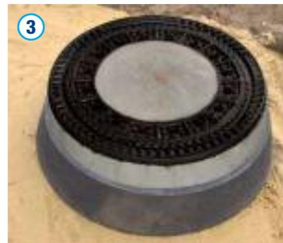
Die Abdeckung ist unter Verwendung von Ausgleichsmörtel (Betonausführung: z. B. Estrichmörtel gemäß DIN 4034/Kunststoffausführung: z. B. Polymermörtel) auf den Auflagering zu setzen. Die Verwendung von Ausgleichsrings ist analog möglich. Die Vorschriften und Richtlinien zum Straßenbau sind zu beachten. Für den EVZ-Wert unter dem Auflagering ist die ZTVE-StB 09 zu berücksichtigen.
