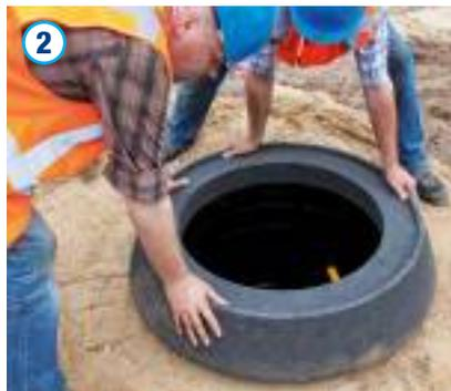
Der Auflagering ist schließlich auf das Auflager aufzusetzen. Hierbei ist eine Setzungsfuge von 20 mm bis max. 50 mm zu realisieren. Punktlasten und Hohlräume sind grundsätzlich zu vermeiden!
