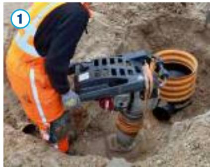
Der Straßenablauf kann nun bis zum Ablaufstutzen mit geeignetem Material verfüllt und von Hand oder mit leichtem Gerät bis zu einer Proctordichte von min. 95% verdichtet werden.
