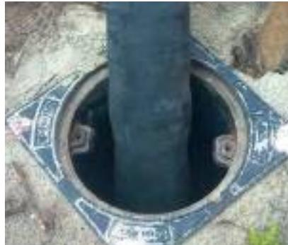
Zum Öffnen der Inspektionsschächte ist gemäß **1. Kontrolle des Schlammfangs** vorzugehen. Sollten Leichtflüssigkeiten auf der Wasseroberfläche der Anlage enthalten sein, sind diese vorab fachgerecht abzusaugen und zu entsorgen. Dieser Vorgang wird bis zur vollständigen Reinigung der Anlage durchgeführt. Durch den Ablaufschacht ist schließlich das Regenwasser mittels Saugschlauch abzusaugen und fachgerecht zu entsorgen.
