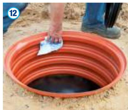
Der Schacht ist lagenweise (max. 30 cm) mit geeignetem Material gemäß DIN 1610 zu verfüllen und zu verdichten. Je nach Abdeckung kann die geforderte Höhe der Verfüllung variieren. Der entsprechende Dichtungsbereich (innen/außen) ist vor dem Einsatz von Dichtungen oder Abdeckungen auf Verunreinigungen zu prüfen und ggf. zu reinigen.
