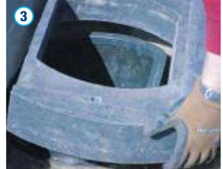
Der Kunststofflastaufnahmering wird auf das verdichtete Auflager aufgesetzt. Je nach Gussaufsatz wird der passende Lastaufnahmering aufgesetzt. Beim Einsatz des Kunststofflastaufnahmeringes und einem entsprechend ausreichend verdichtetem Auflager kann der Lastabtrag direkt ohne Einsatz von Ortbeton ins Erdreich erfolgen. Punktlasten und Hohlräume sind zu vermeiden.
