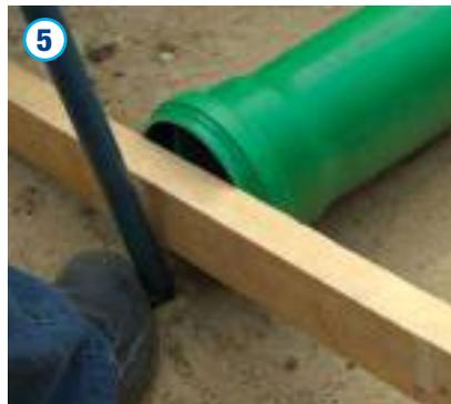
Rohre kleiner Nennweiten sind leicht von Hand zusammenschieben; für größere Nennweiten sind ggf. Hilfsmittel zu verwenden. Ein Zusammenschieben z. B. mit Hilfe eines Baggerlöffels ist aufgrund unkontrollierter Kraftentfaltung und Rohrbeschädigungen nicht zulässig.
