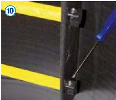
Unter Umständen ist zur Einhaltung der Steigmaße hierbei ein Umsetzen der gelben GFK-Stufen erforderlich. Hierzu sind die Schrauben an den Endkappen der Stufen herauszuschrauben. Die Endkappen sind abzuziehen und die Stufen auf das entsprechende Steigmaß von 250 mm umzusetzen. Danach sind die Endkappen wieder aufzusetzen und mittels Schrauben zu sichern.
