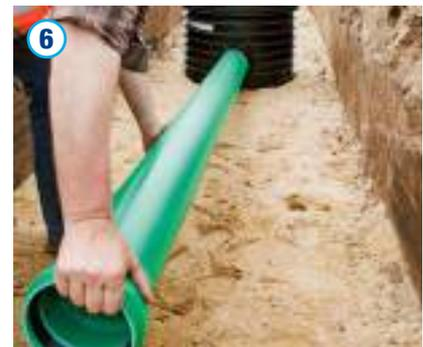
Nach dem Einstecken ist die Rohrführung gemäß den Planungsvorgaben auszurichten. Hierzu kann das Rohr aufgrund von integrierten Kugelgelenken stufenlos in die erforderliche Richtung abgewinkelt werden. Es lassen sich hierbei sowohl Richtungsänderungen im Bereich von 15° als auch Gefälle von bis zu 13 % realisieren.
