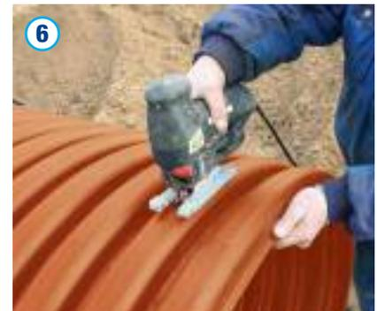
Für den weiteren Schachtaufbau ist das Schachtrohr, falls erforderlich, entsprechend der gewünschten Einbautiefe abzulängen. Hierzu ist das Schachtrohr mit Hilfe einer Säge auf einer Außenwelle (äußerster Profilpunkt) zu durchtrennen und die Trennkante sauber umlaufend zu entgraten.
