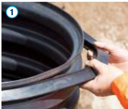
Aus Feinsand bzw. Splitt ist ein Auflager gemäß Vorgaben herzustellen. Zum Abziehen kann dabei z. B. eine Abziehschablone von Wavin verwendet werden. Das Dichtelement DN600 ist dann zwischen der ersten und zweiten Außenwelle am Konushals zu montieren. Sowohl die Dichtung als auch die Dichtfläche des Auflageringes sind gleichmäßig mit Gleitmittel zu versehen.
