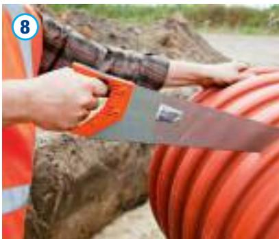
Falls nötig, ist das Schachtrohr entsprechend der Einbautiefe abzulängen. Hierzu ist das Schachtrohr mit Hilfe einer Säge auf einer Außenwelle (äußerster Profilpunkt) zu durchtrennen und die Sägekante abschließend zu entgraten.
