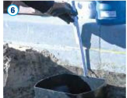
6 Zur Höhenanpassung kann die Steckverbindung zwischen Grundkörper und Ablaufoberteil um max. 40mm hochgezogen werden.
