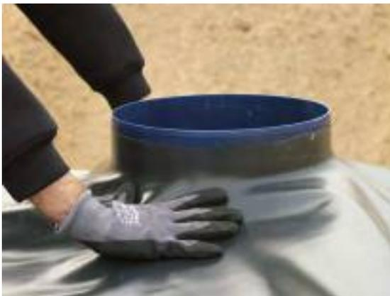
Auch im Bereich der Schachtheadapter ist das Vorgehen identisch. Der Vliesstoff wird kreuzförmig eingeschnitten und über den Adapter geschoben. Auch hier ist darauf zu achten, dass es keine Risse oder Öffnungen gibt, durch die Verfüllmaterial in die Rigole gelangen kann.
