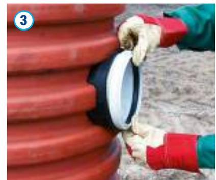
Anschließend ist das Anschluss-Stück DN/OD 110 bzw. DN/OD 160 in die Gummimanschette einzustecken. Das Spitzende des anzuschließenden Rohres ist gemäß Herstellerangaben anzufasen, mit Gleitmittel zu versehen und in das Anschluss-Stück einzustecken. Hierbei ist darauf zu achten, dass das Anschluss-Stück frei von Verunreinigungen ist.
