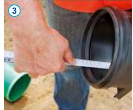
Die Einstecktiefe (Muffentiefe des Schachtbodens) ist auf dem Spitzende der anzuschließenden Schmutz- oder Regenwasserleitung zu markieren. Anhand der Markierung kann kontrolliert werden, ob das Rohr bis zum Anschlag in den Schachtboden eingeschoben worden ist. Das Spitzende des anzuschließenden Rohres ist gemäß Herstelleranweisung anzufasen und zu entgraten.
