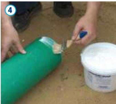
Das Spitzende sowie die Muffeninnenfläche müssen sauber und frei von Beschädigungen sein, sonst ist das Rohr zu reinigen oder auszutauschen. Der korrekte Sitz der Dichtungen in der Muffe ist zu überprüfen. Das markierte Spitzende ist gleichmäßig und umlaufend mit Gleitmittel zu versehen und dann bis zum Anschlag in die Muffe einzuschieben.
