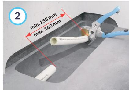
2 Beschädigte oder undichte Rohrbereiche herauschneiden.
