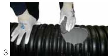
4. Veillez à ce que le raccord de piquage soit bien propre au moment du placement. Ensuite introduisez le raccord de piquage dans le trou foré (ne pas utiliser de lubrifiant), jusqu'à ce que le profil du raccord de piquage s'emboîte parfaitement dans le profil du tuyau X-Stream.
