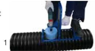
2. Le forage du tuyau X-Stream se réalise avec une scie-cloche spécialement adaptée ( $\text{Ø } 177\text{mm} \pm 0,5\text{mm}$ ) y compris une scie de centrage. Le forage doit être perpendiculaire au cœur du tuyau. L'utilisation d'un support de perceuse est nécessaire. Positionnez la scie de centrage entre les 2 profils sur le fond profilé. Le montage du raccord de piquage est uniquement autorisé conformément au dessin entre  $45^\circ$  et  $135^\circ$ .
