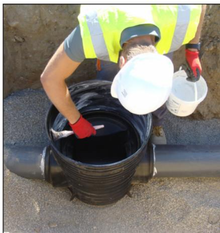
**C - Assembler l'élément de rehausse en exerçant une pression verticale.**
