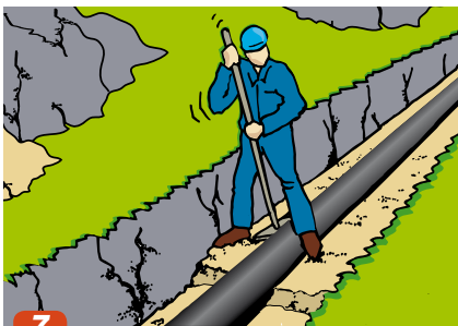
7 Det är viktigt att understoppning utförs på den undre 1/4 delen av röret så röret får ett bra stödfundament.
