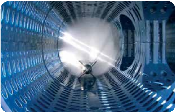
Fase di risciacquo nel canaletto di drenaggio Q-Bic
